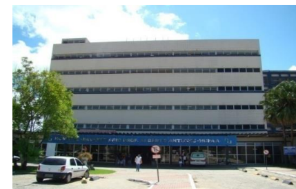
Figura - Fachada do Hupaa.
