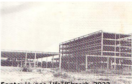
Figura - 1ª Fase da obra do Hupaa – década 60.
