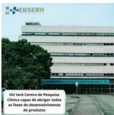
Figura 76 – Início das obras do Centro de Pesquisa clínica do Hupaa, 2023.
