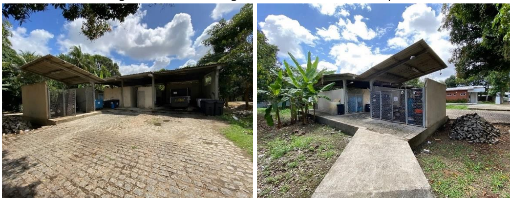
Figuras 16 e 17 - Visão geral do armazenamento temporário
