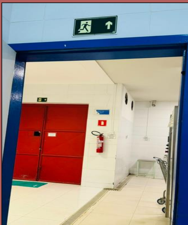
10/07/2024 SALA DE PREPARO PARA SAÍDA DE EMERGÊNCIA
