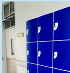
Instalação de boxes no vestuário de paramentação e de lockers para guarda de pertences no 4º e no 5º andar do ECI
