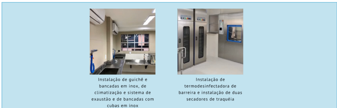
Figura 7. Adequação do espaço para instalação provisória da área de lavagem e área administrativa da Unidade de Processo de Materiais Esterilizados (UPME)
