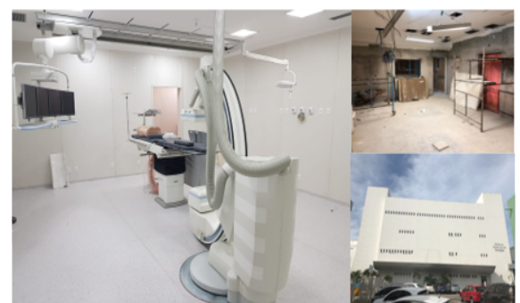
Figura 20. Centro de Diagnóstico por Imagem com instalação do angiógrafo e foto durante a obra
