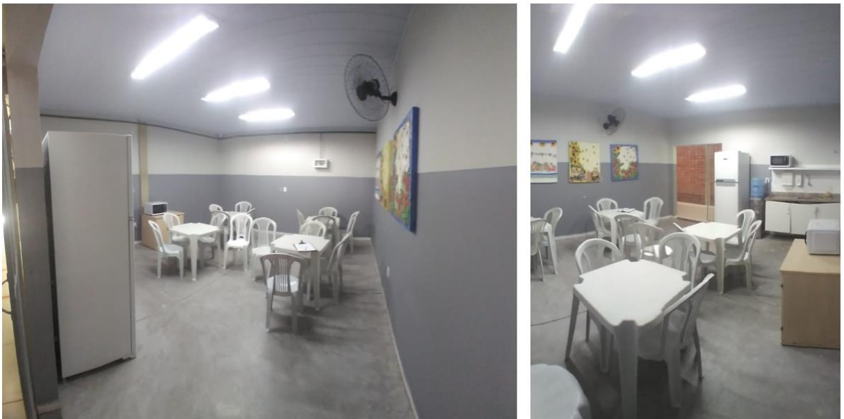
Figura 37 - Reforma do Refeitório II.
