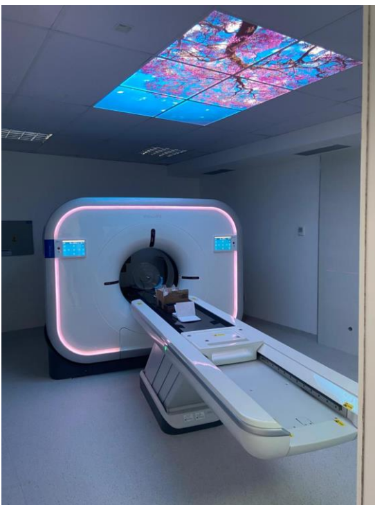
Figura 26 - Reforma do serviço de tomografia.
