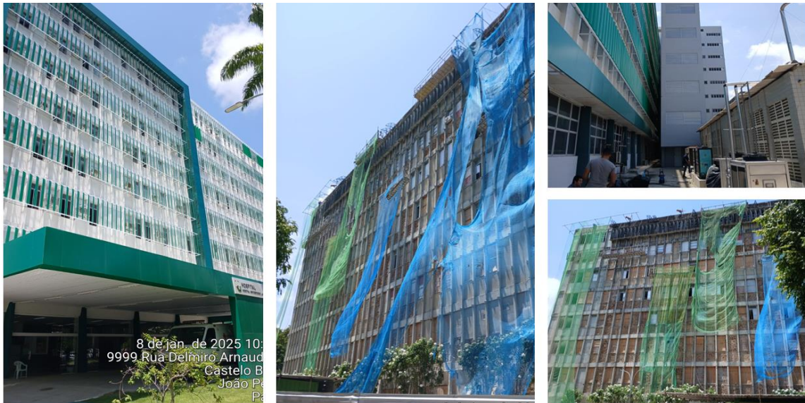
Figura 25 - Evolução da obra da fachada e rampa de emergência.
