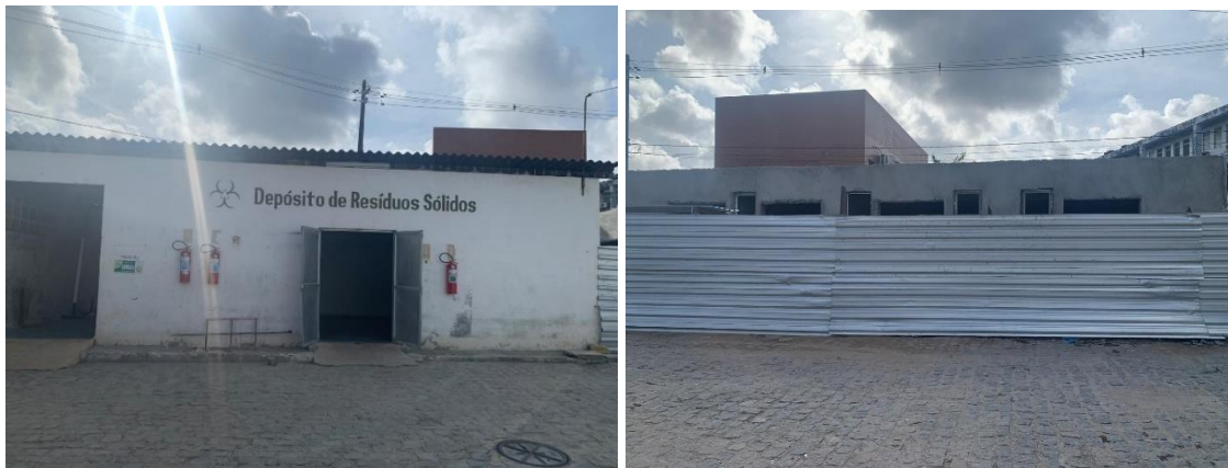
Figura 22 - Abrigo de resíduos antes da obra.
