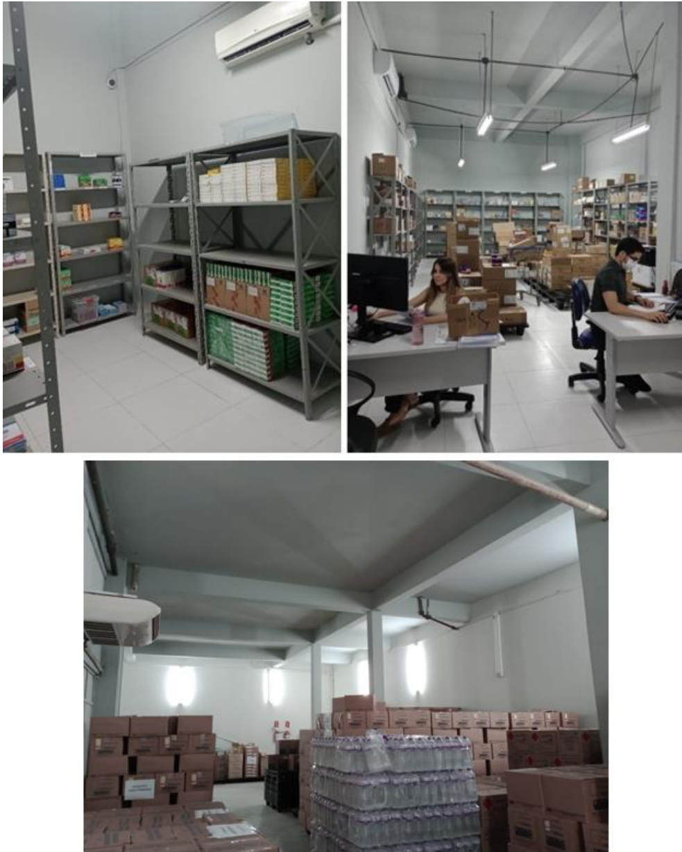
Figura - Almoxarifado 1 (Medicamentos) reformado - instalação de novo piso, reforma da parede para fechamento dos combogós e renovação da pintura
