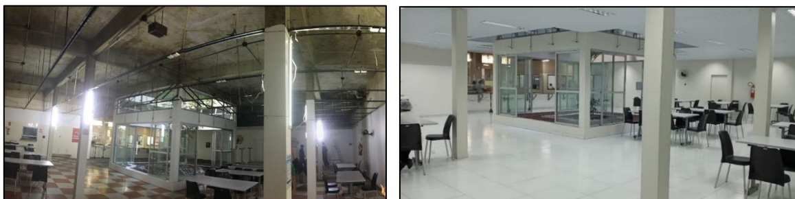
Figura 7 - Reforma do Refeitório (antes e depois).
