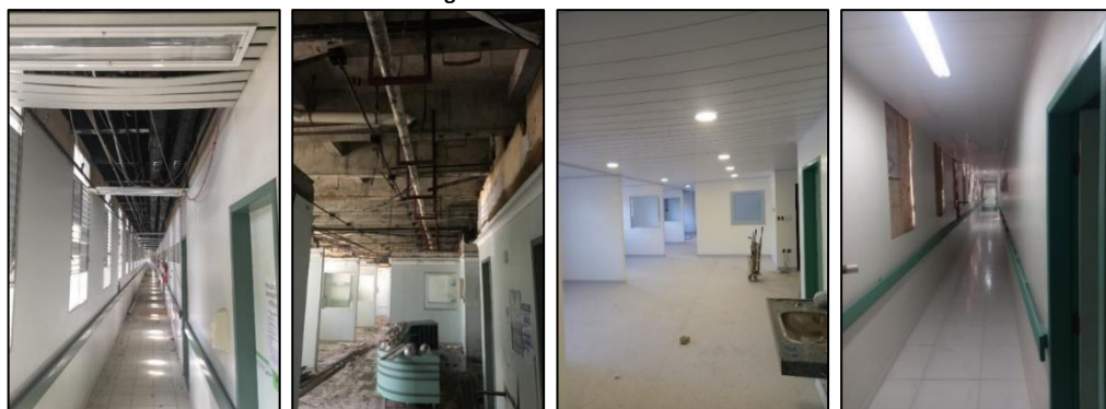
Figura 5 - Reforma das UTIs
