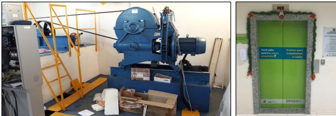
Figura 6 - Reforma dos elevadores.
