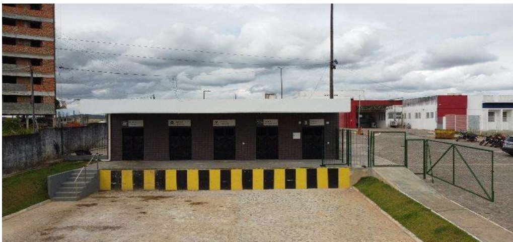
Imagem 37: Abrigo de resíduos
