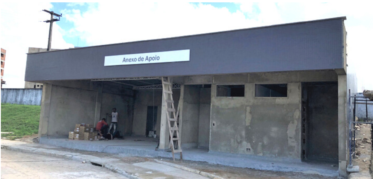
Acompanhamento de obras em andamento (novo abrigo de resíduos, anexo de apoio, área de vivência)
