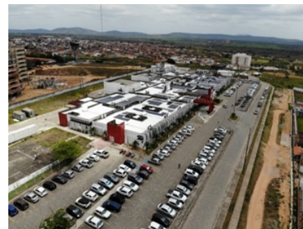
Figura 11. Foto do telhado com as placas solares – 2022
