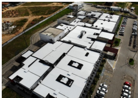
Figura 10. Foto da cobertura do telhado, após revitalização – 2021
