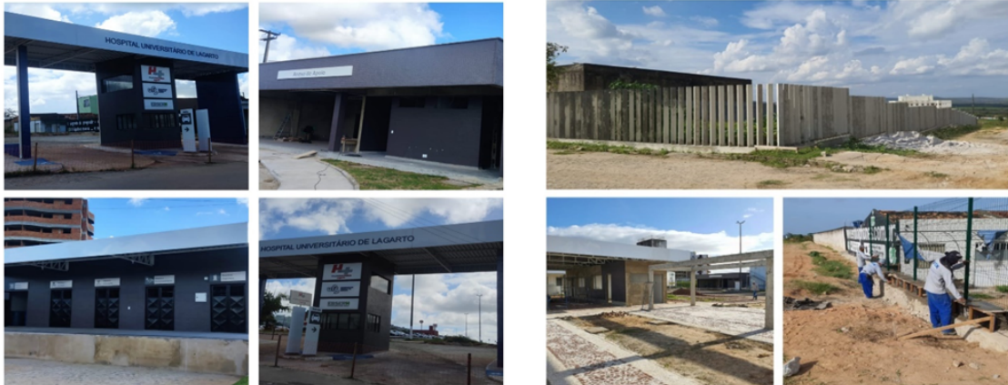
Figura 12. Obras em execução – 2022
