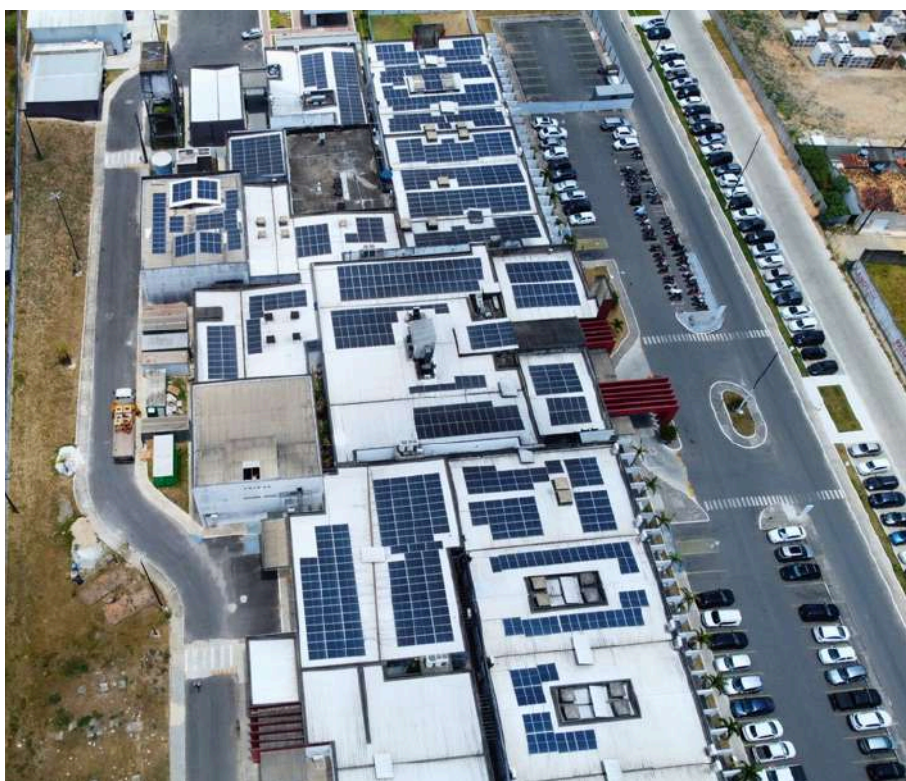
PLACAS FOTOVOLTAICAS/ TRATAMENTO ÁGUA
