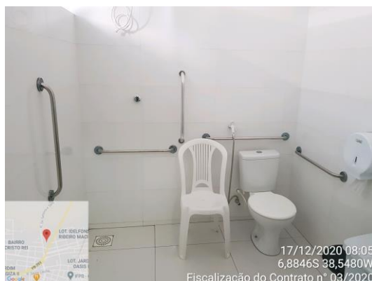
Figura 6. Reformas internas no HUIB
