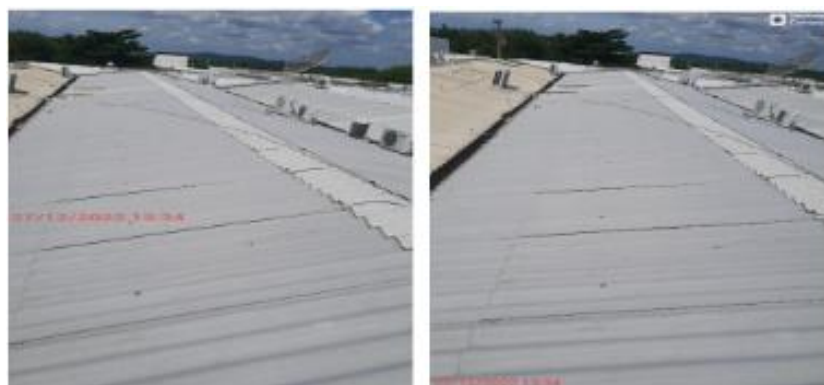
Figura 6. Manutenção do Sistema de Cobertura do HUJB
