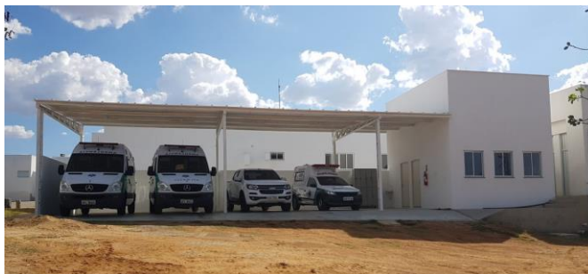
Figura 4. Construção da Garagem para os veículos Oficiais do HUJB
