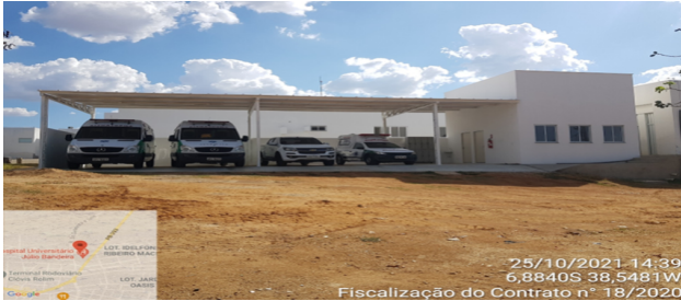
Figura 1. Garagem veículos oficiais do HUIJB
