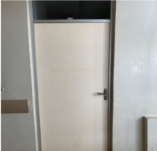
Figura 12 – Sala de utilidades (abrigo temporário)
