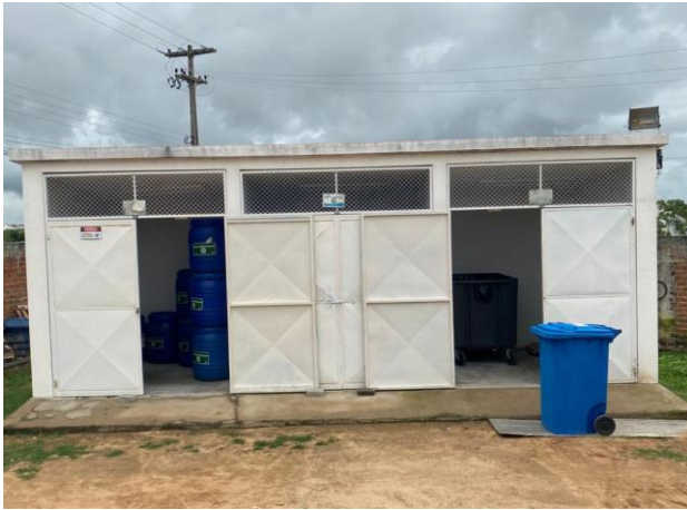
Figura 14 – Armazenamento externo – visão externa
