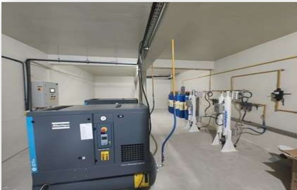
Figura 11 – Implantação da Central de Ar comprimido
