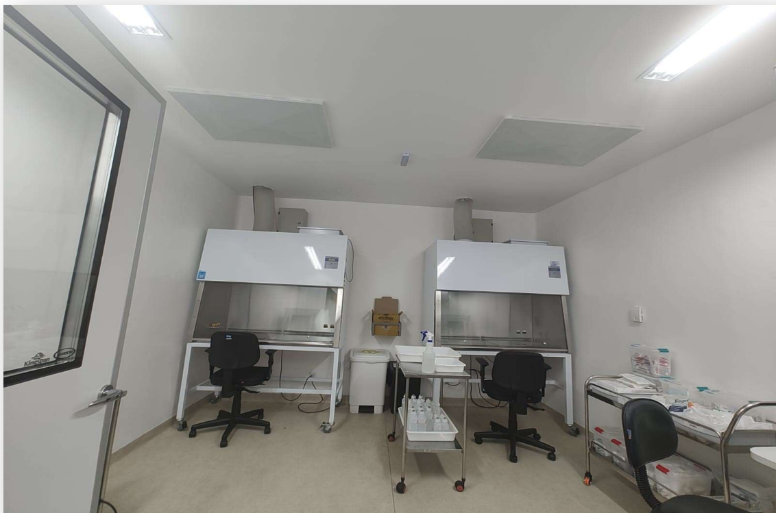
Figura 8 – Reforma da sala de manipulação dos quimioterápicos para instalação das novas cabines de segurança biológica
