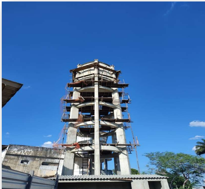
Figura 1 – Obra da caixa d'água para o sistema de combate a incêndio
