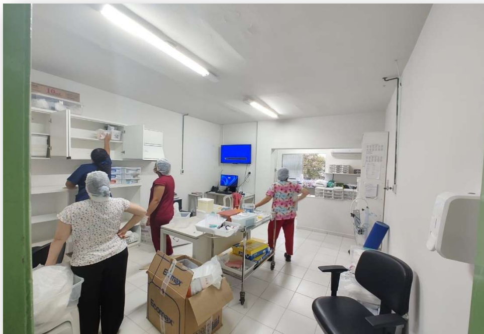
Figura 7 – Reforma da nova sala para posto de enfermagem da Oncopediatria
