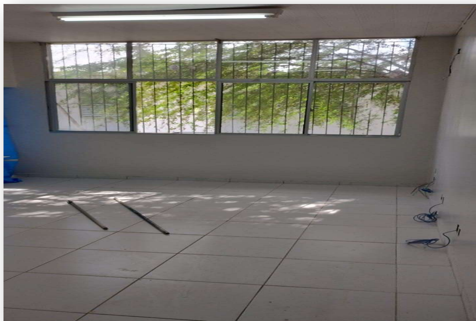
Figura 10 – Reforma da sala da DIVGP
