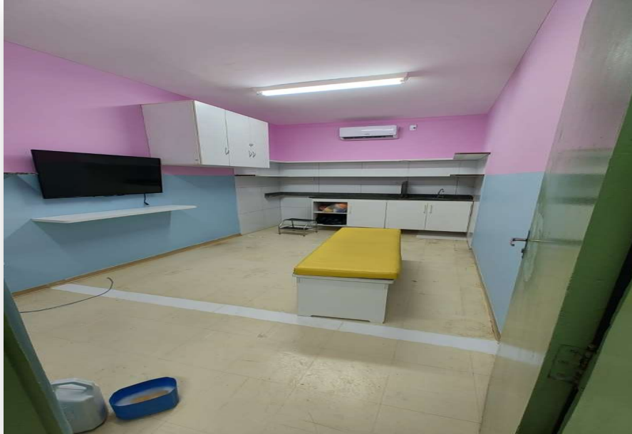
Figura 6 – Reforma da nova sala da brinquedoteca
