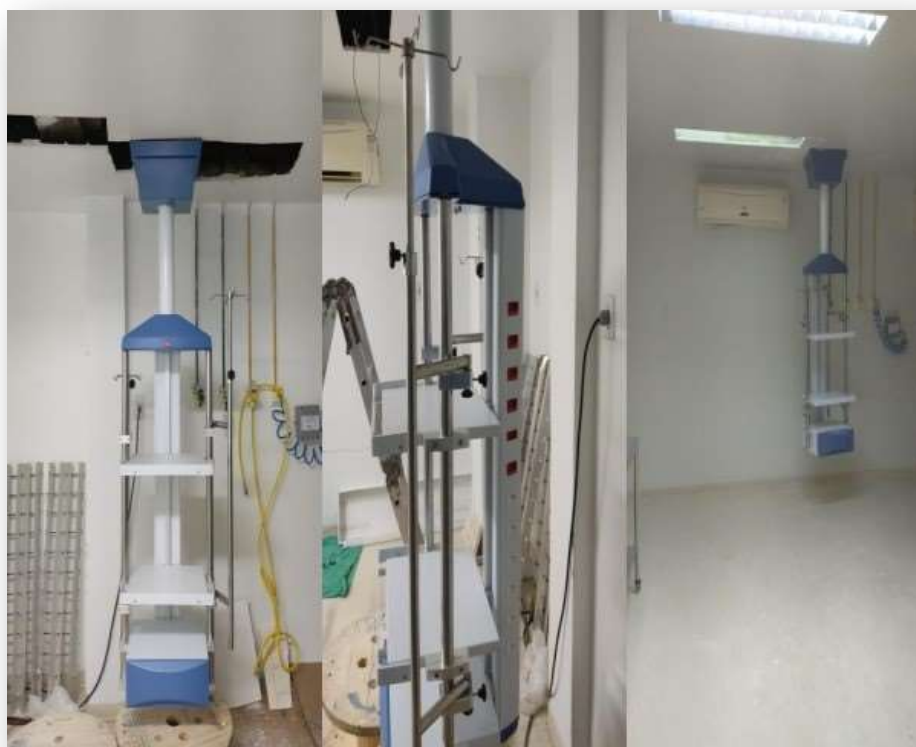
Figura 13 – Instalação de estativas nas salas cirúrgicas
