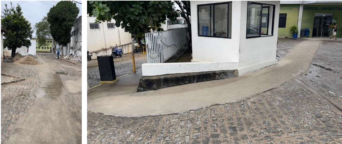
Depois da intervenção: Fonte própria, 2025.
