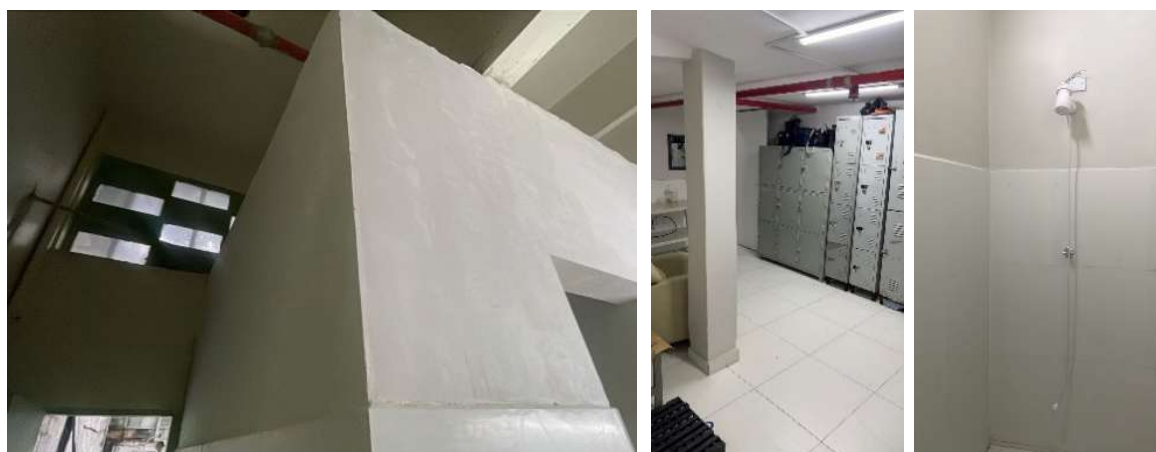
Depois da intervenção: Fonte própria, 2025.
