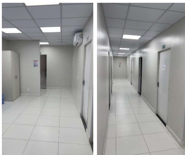
Depois da intervenção: Fonte própria, 2025.
