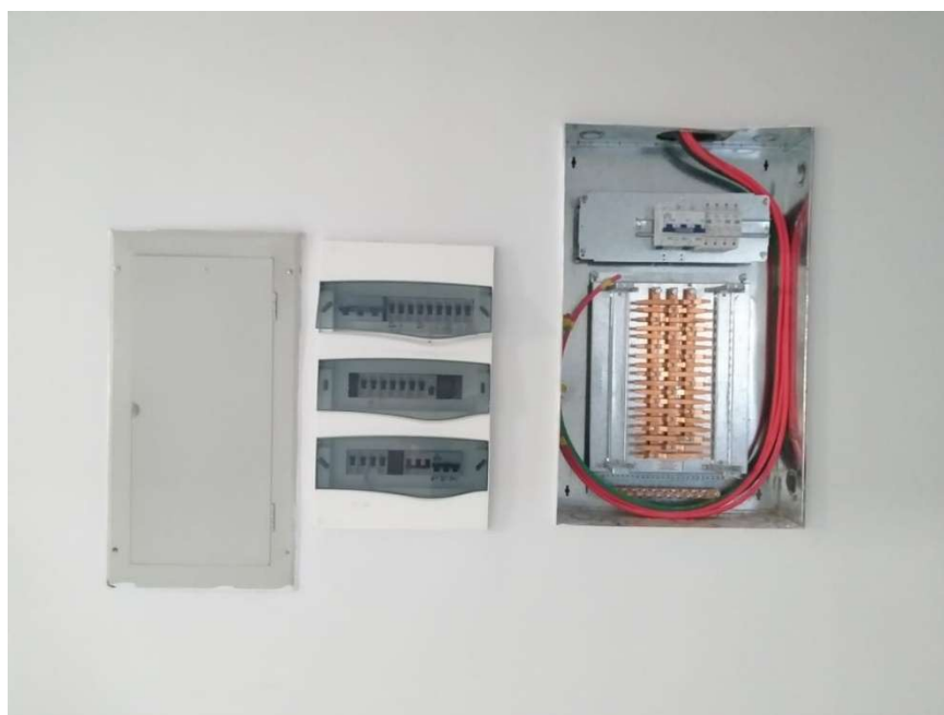
Depois da intervenção: Fonte própria, 2025.
