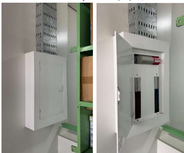
Depois da intervenção: Fonte própria, 2025.
