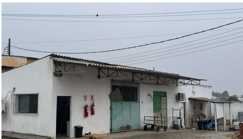
Depois da intervenção: Fonte própria, 2025.
