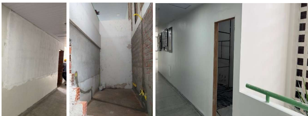
Depois da intervenção: Fonte própria, 2025.
