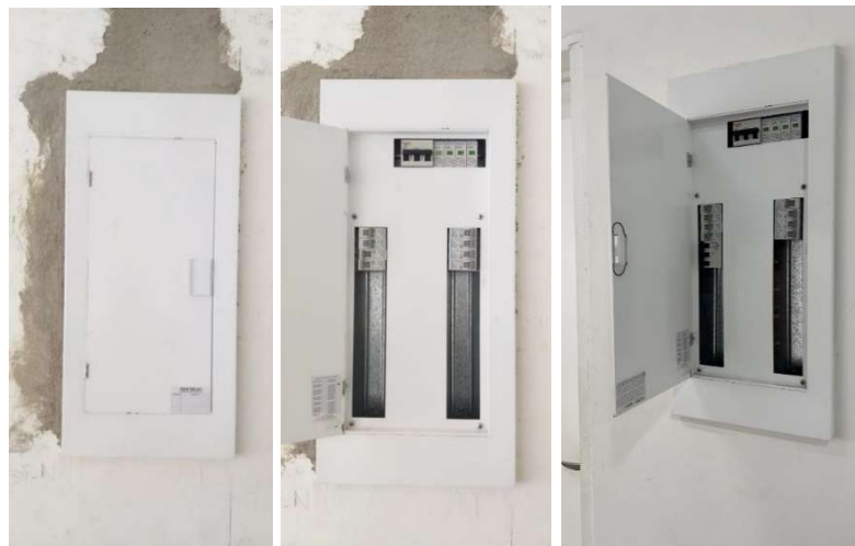
Depois da intervenção: Fonte própria, 2025.
