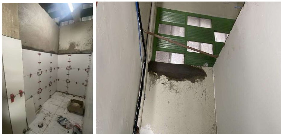
Durante a intervenção: Fonte própria, 2025.
