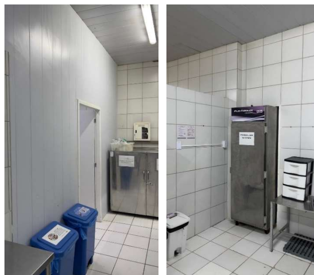
Depois da intervenção: Fonte própria, 2025.
