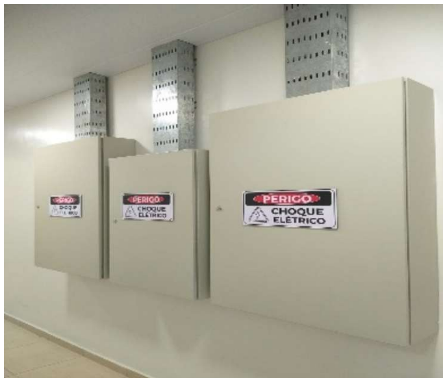
Depois da intervenção: Fonte própria, 2025.
