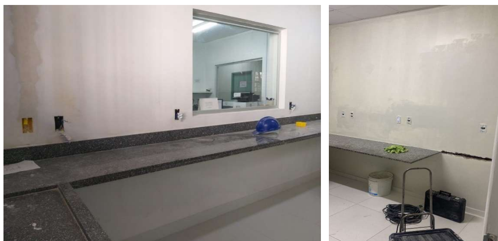
Durante a intervenção: Fonte própria, 2025.
