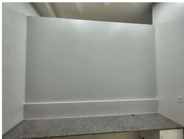
Depois da intervenção: Fonte própria, 2025.
