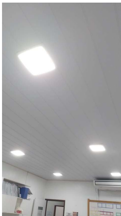
Depois da intervenção: Fonte própria, 2025.
