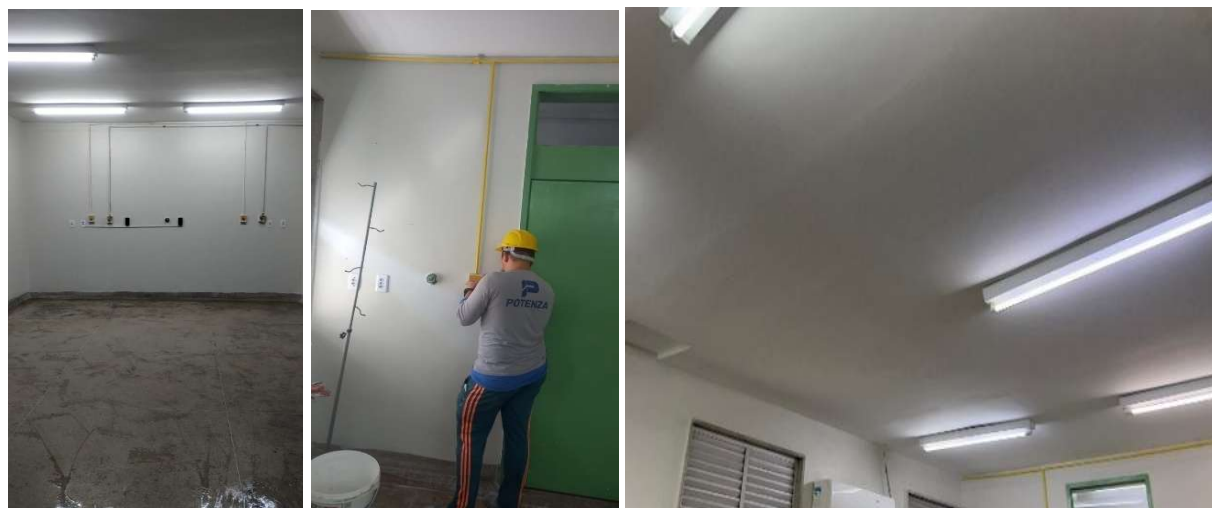
Depois da intervenção: Fonte própria, 2025.
