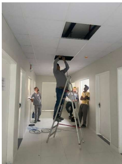
Depois da intervenção: Fonte própria, 2025.
