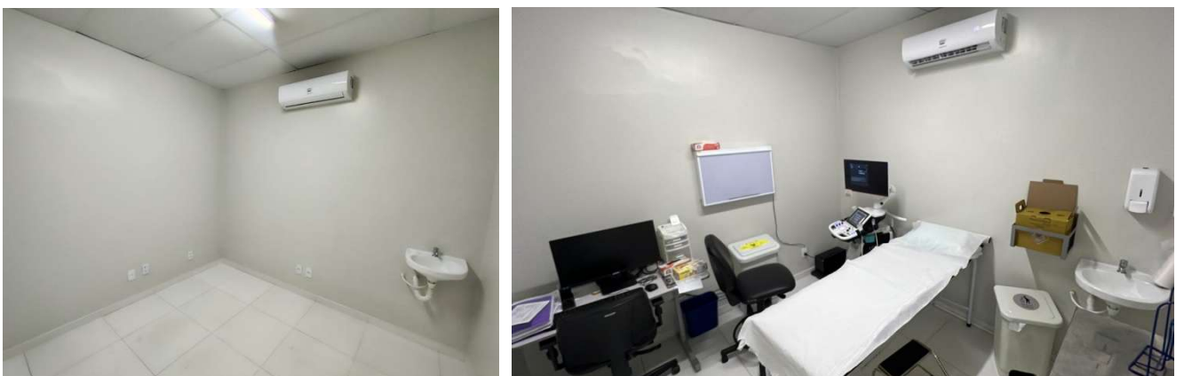
Depois da intervenção: Fonte própria, 2025.
