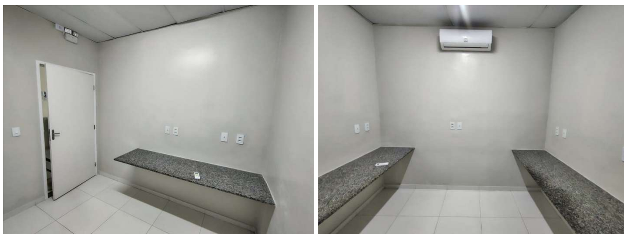
Depois da intervenção: Fonte própria, 2025.
