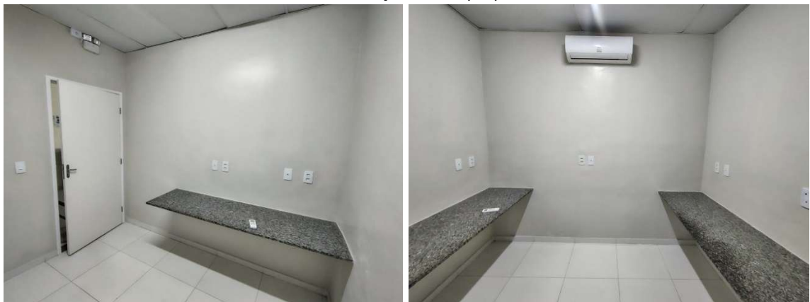
Depois da intervenção: Fonte própria, 2025.
