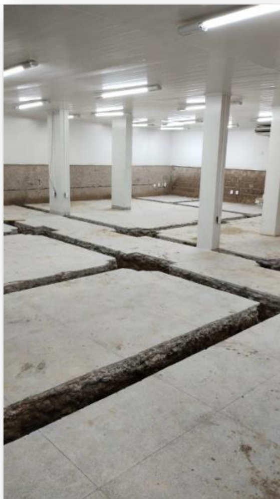
Figura 15 – Obra do Centro de Simulação Realística
