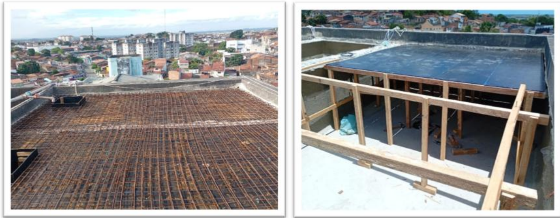
Figura 37: Reforma/Recuperação Estrutural da Caixa D'água
