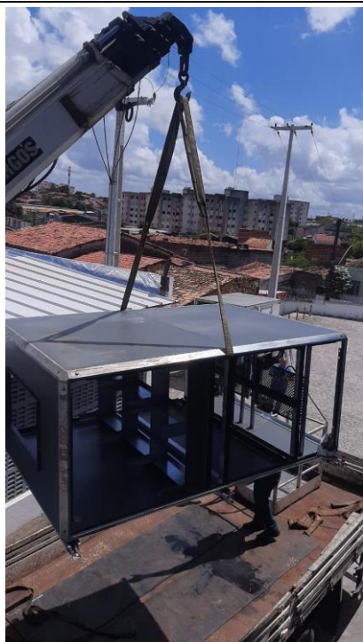
Estrutura metálica de suporte
