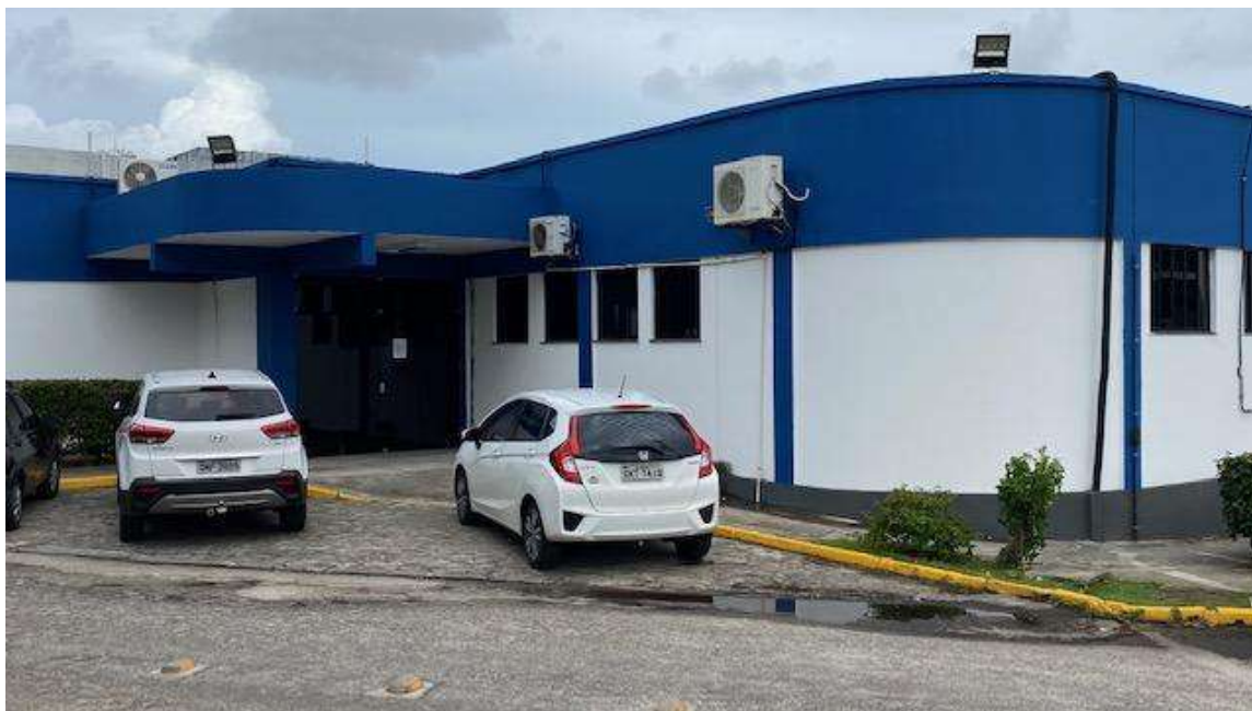
IMAGEM 131 - Pintura do Prédio da Hanseníase - 2017
