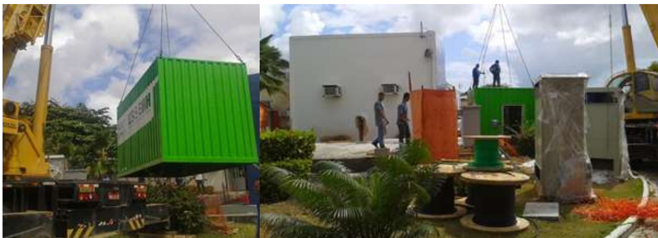
IMAGEM 96 - Instalação do Datacenter.
