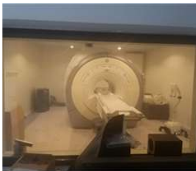
IMAGEM 12 - Ressonância Magnética Instalada
