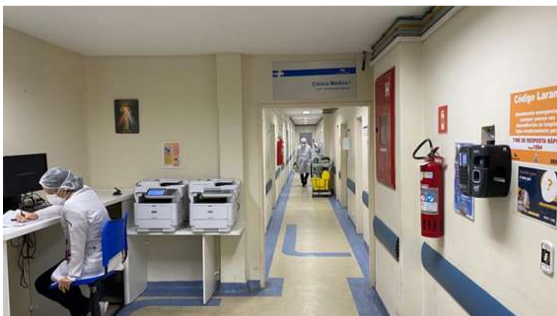
IMAGEM 110 - Reforma e Adequação das Clínicas Médicas e Cirúrgicas I e II - 2015
