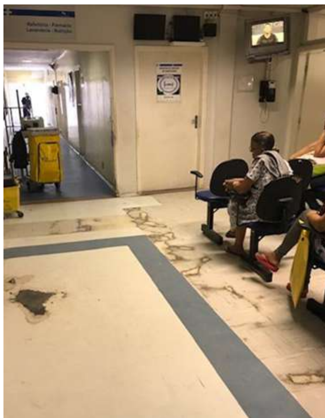
IMAGEM 139 - Reforma do Hall de Entrada e Escada do Prédio do HU - 2017
