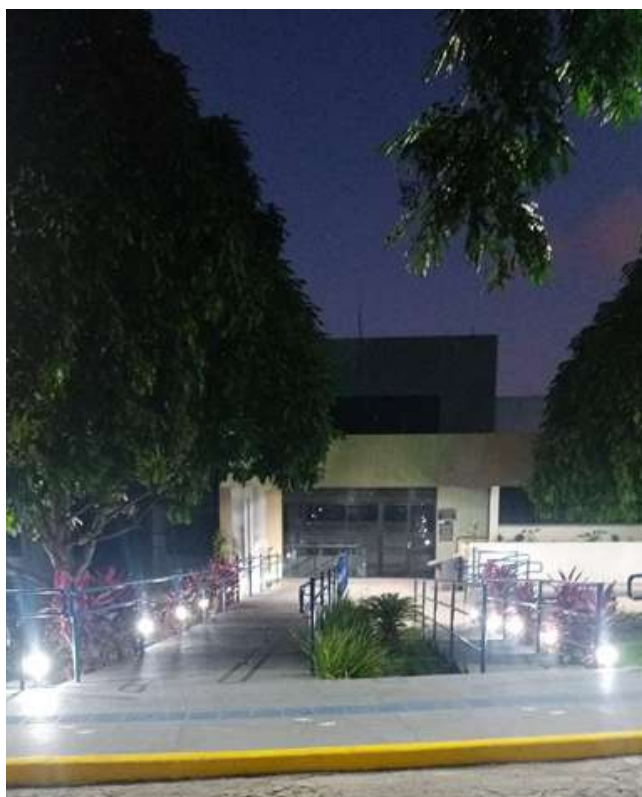
IMAGEM 148 - Instalação de Lâmpadas em LED em Todos os Prédios e Áreas Externas
