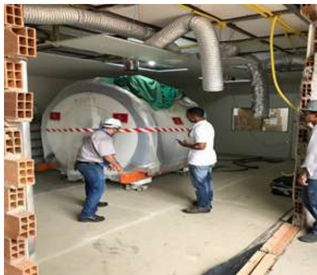
IMAGEM 11 - Montagem da Ressonância Magnética
