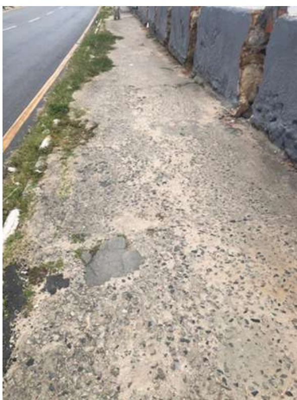
IMAGEM 112- Muro e Passarela Externa de Acesso ao HU em Reforma
