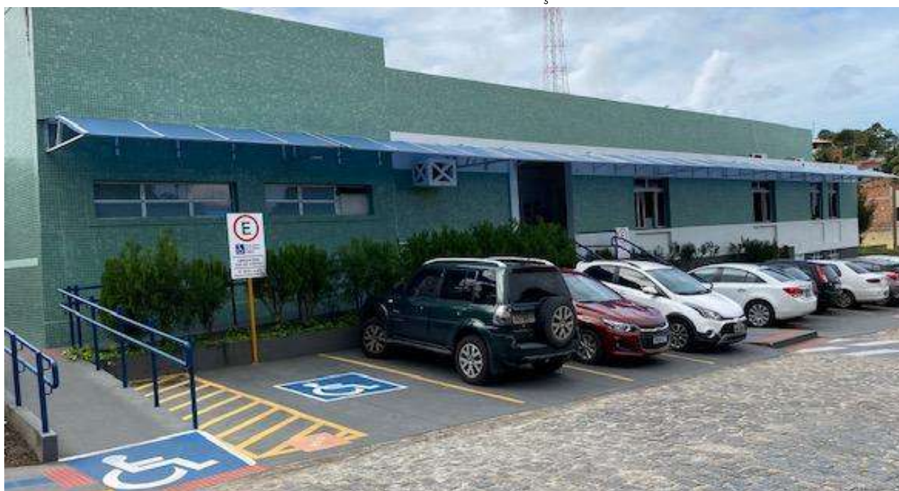
IMAGEM 184 - Revestimento Fachada Administração - 2020
