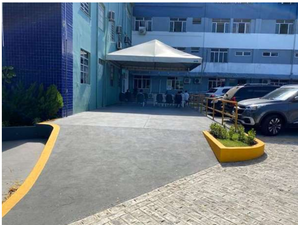
IMAGEM 122 - Rampa (Acessibilidade) - Prédio Administração
