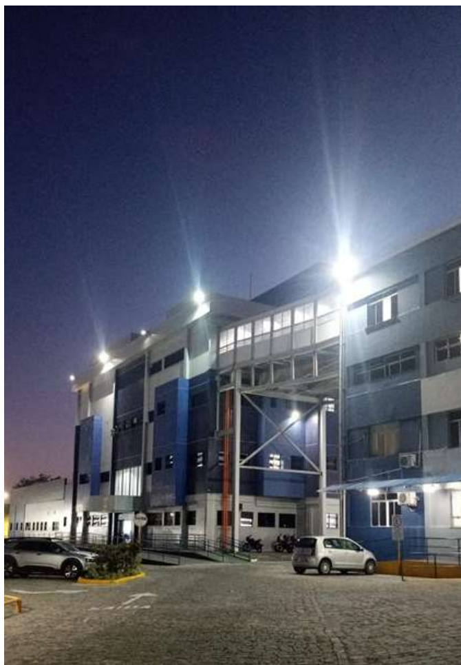
IMAGEM 150 - Instalação de Lâmpadas em LED em Todos os Prédios e Áreas Externas
