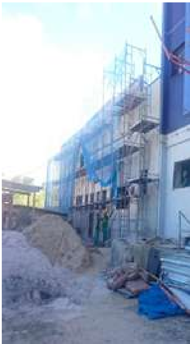
IMAGEM 10 - Reforma do Anexo Hospitalar (2016)
