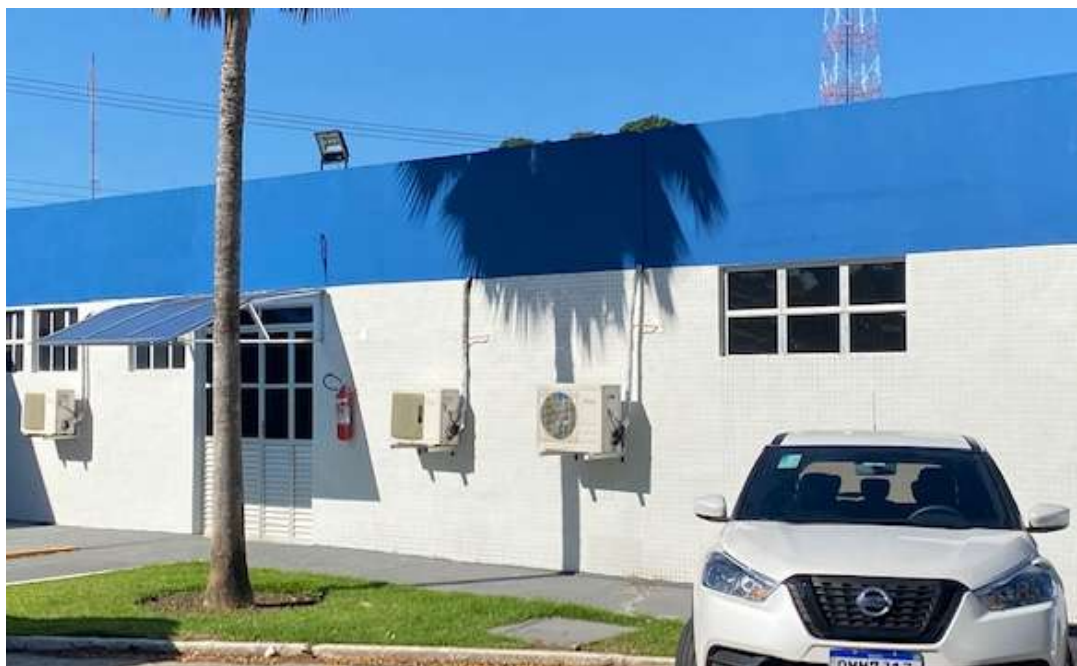
IMAGEM 143 - Reforma da Agência Transfusional - 2017
