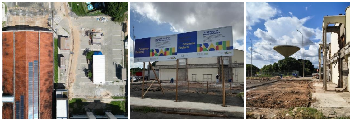
Imagens da obra da Hemodinâmica
