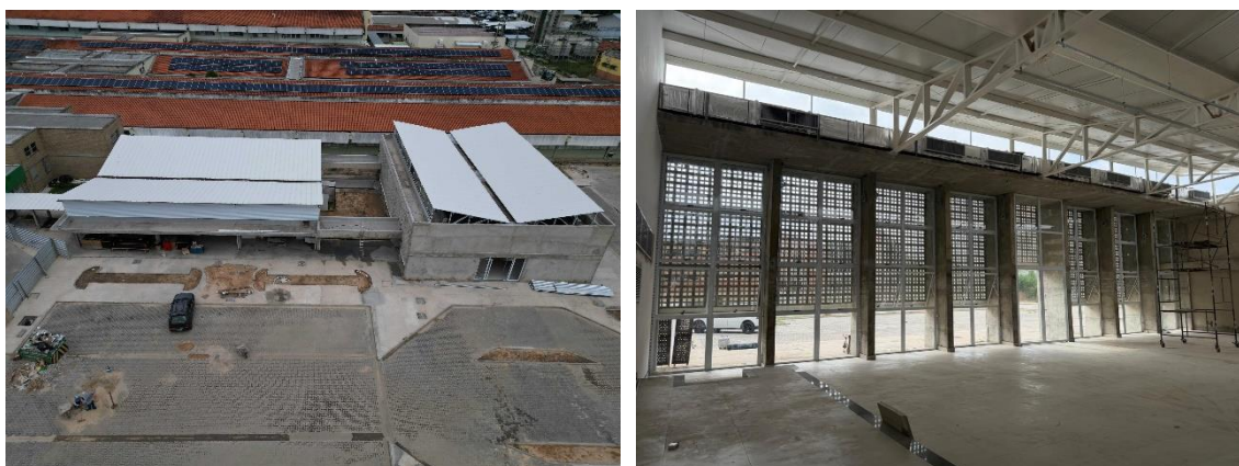
Imagens da obra do Centro de Convivência
