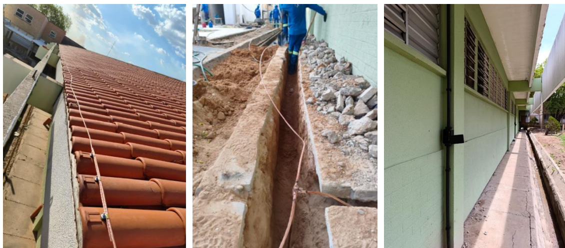
Imagens da obra de implantação do Sistema de Proteção Contra Descargas Atmosféricas - SPDA Fonte: Arquivo do Setor de Infraestrutura Física do HU – UFPI
