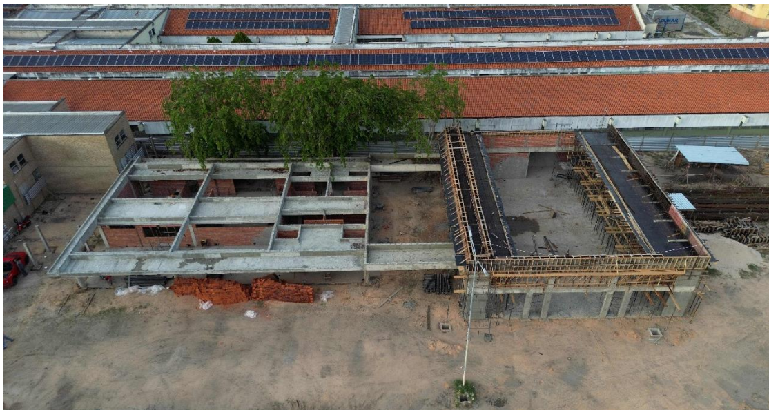
Figura 6 - Obra do Centro de Convivência (26/11/2024).
