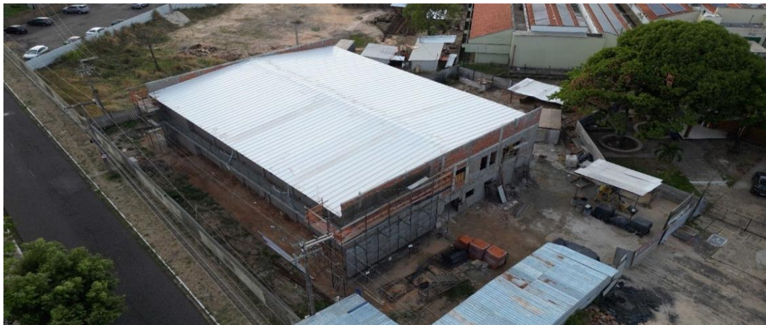
Figura 5 - Obra do Centro de Apoio Acadêmico (26/11/2024)
