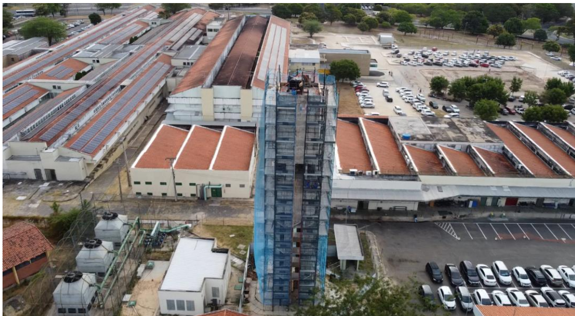
Figura 3 - Reforma estrutural dos reservatórios (dez/2023).
