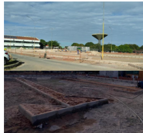
Figura 14. Obra de reforma dos estacionamentos
