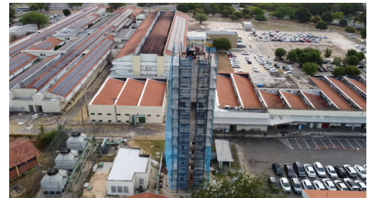
Figura 4. Vista da obra de reforma do estacionamento e dos reservatórios – 2022
