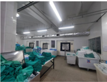
Figura 13. Reforma da lavanderia e UPME
