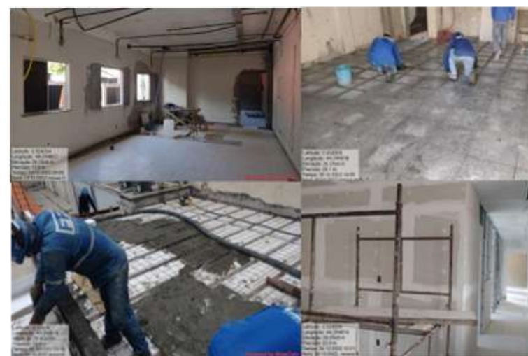
Figura 12. Continuação das obras na Unidade de Diagnóstico por Imagem
