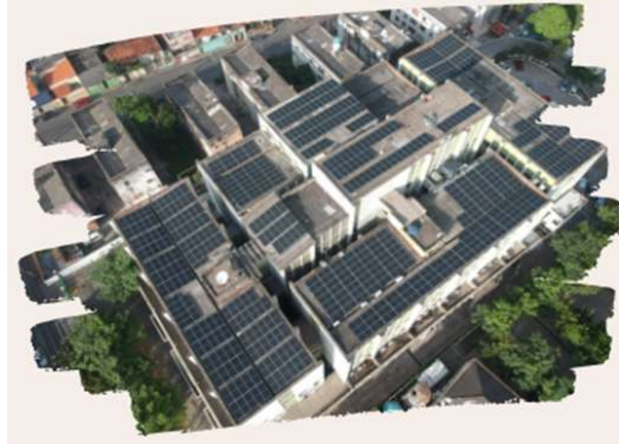
Figura 42. Cobertura da Unidade Materno Infantil com usina fotovoltaica
