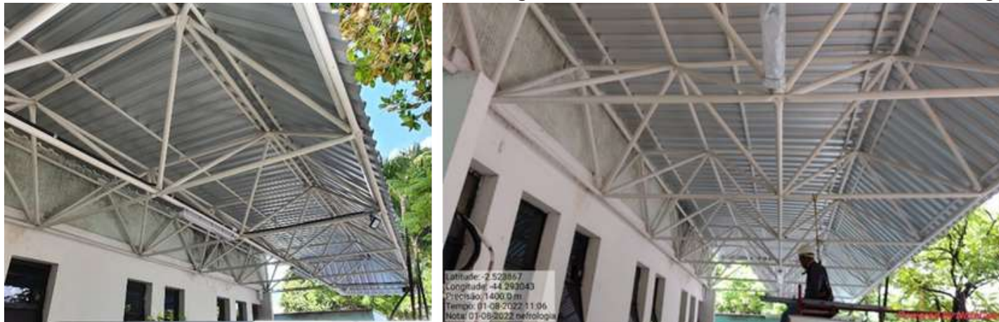
Figura 40. Cobertura no acesso à Unidade de Nefrologia
