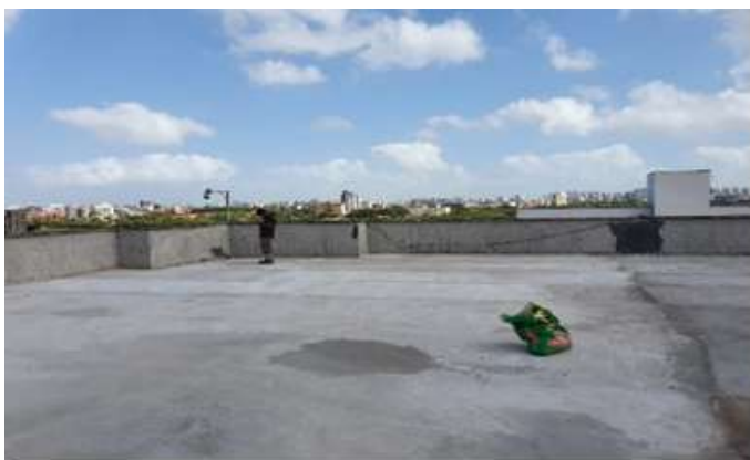
Figura 39. Impermeabilização da laje do Bloco C
