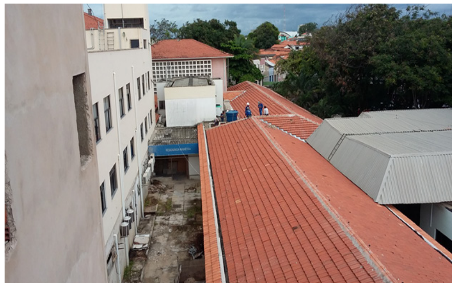
Depois da reforma (Telhado HUPD)
