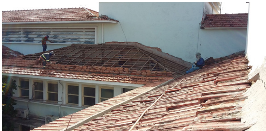
Reforma (Telhado HUPD)
