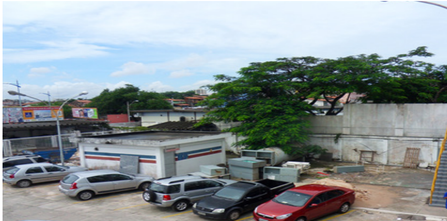
Antes da reforma (Subestação HUMI)
