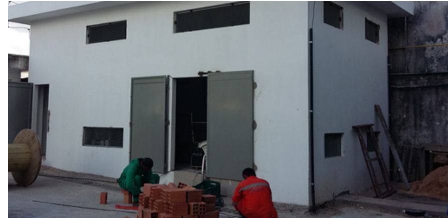
Durante a reforma (Subestação HUMI)
