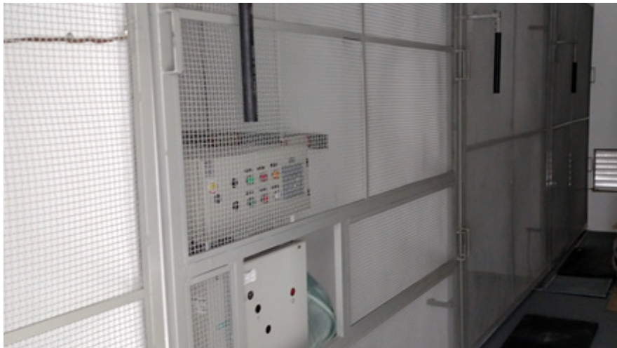
Depois da reforma (Subestação HUMI)
