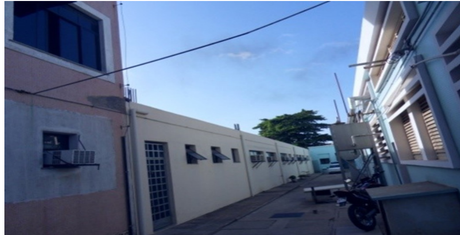
Antes da Reforma
