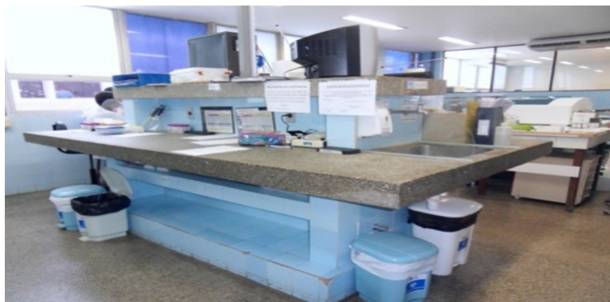
Antes da Reforma
