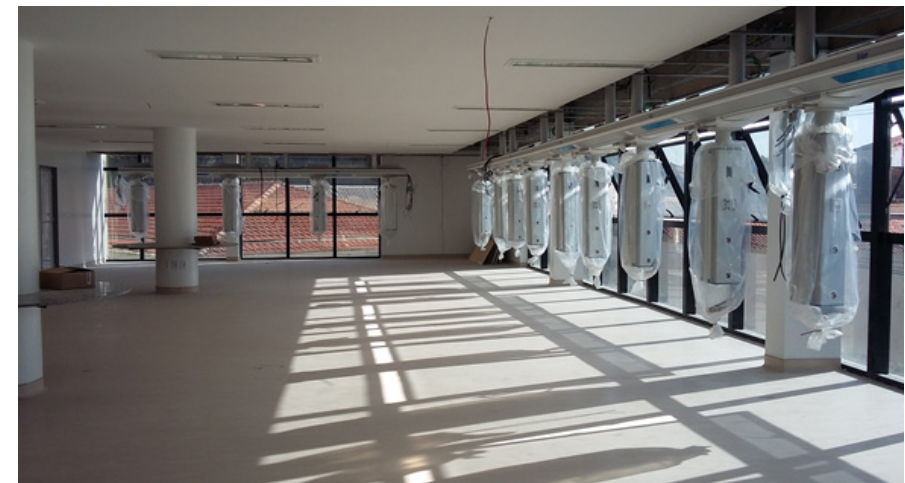
Depois da Reforma
