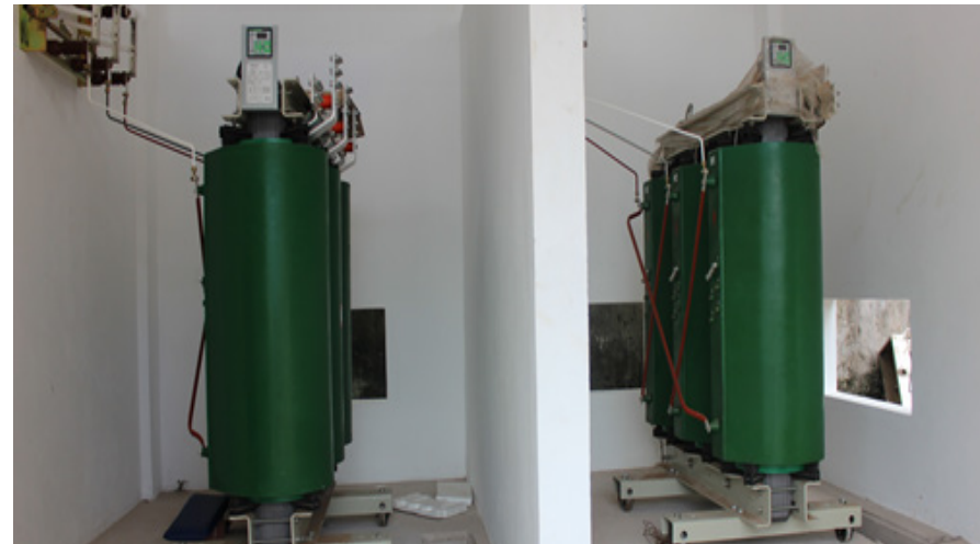
Depois da reforma (Subestação HUMI)
