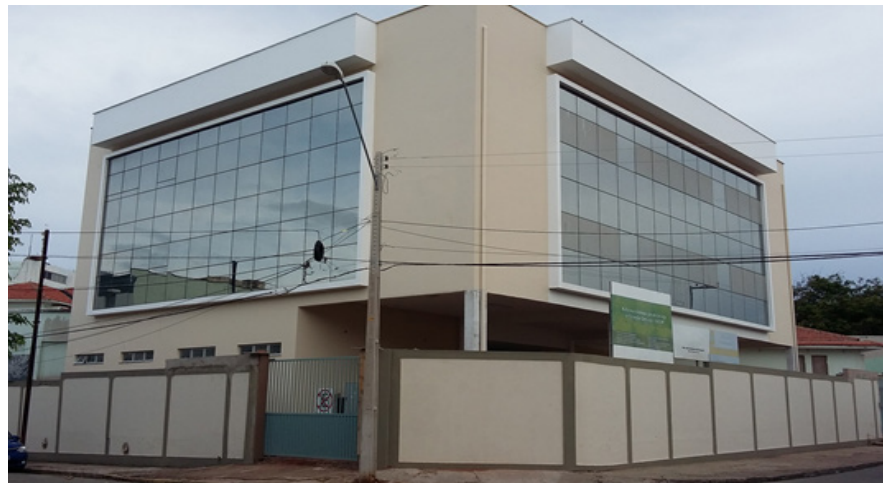
Depois da Reforma
