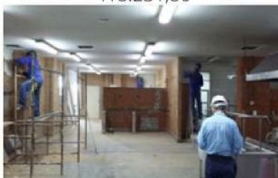
Figura 8. Reforma da Unidade de Alimentação e Nutrição - UMI. R$ 418.231,80
