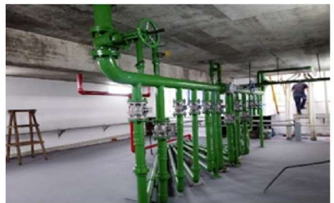
Figura 20. Modernização barrilete Distribuição água - UMI
