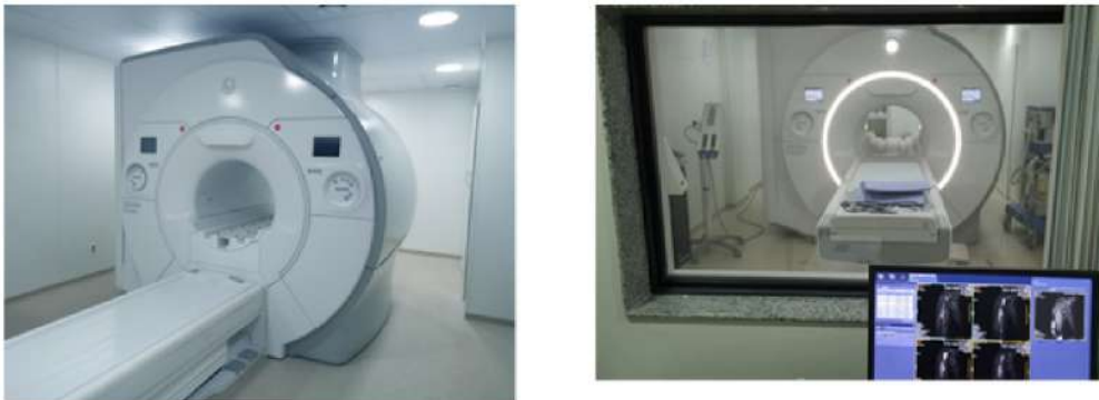
Figura 29: Reforma e adequação da Unidade de Diagnóstico por Imagem na Unidade Presidente Dutra – 1ª etapa concluída
