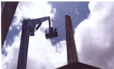
Figura 23. Demolição Chaminé das Antigas Caldeiras da UDP
