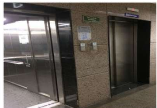
Figura 15. Modernização estrutural de 02 elevadores da Unidade Materno Infantil
