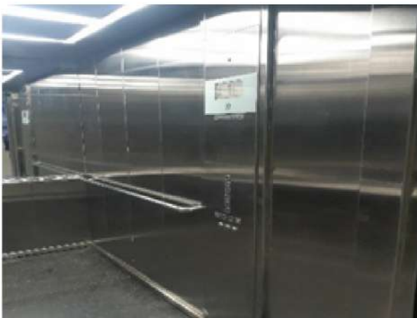
Figura 19. Modernização 02 elevadores - UPD
