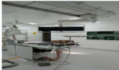
Figura 12. Obra de implantação da nova sala de exames do Laboratório de Hemodinâmica. R$ 455.193,33
