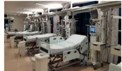
Figura 13. Finalização das obras de ampliação do Bloco C - UPD. R$ 7.038.919,02
