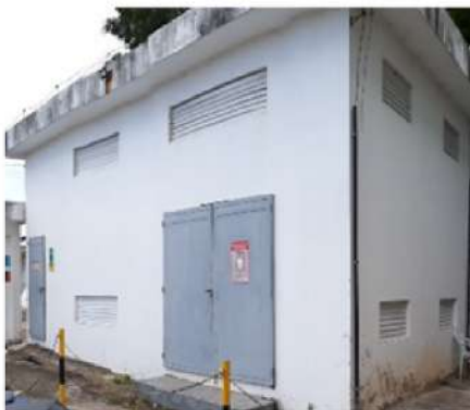
Figura 14. Reforma e adequação das instalações físicas da subestação da Unidade Materno Infantil
