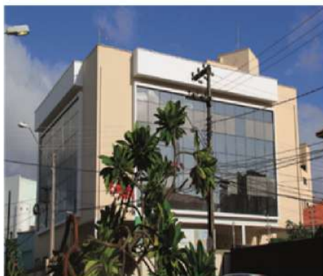
Figura 26. Adequação das novas instalações das Unidades de Terapia Intensiva Adulto e Coronariana no Bloco C da UDP
