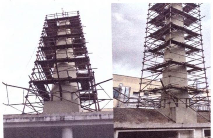
Figura 36 – Demolição da chaminé das antigas caldeiras do HU-UFMA
