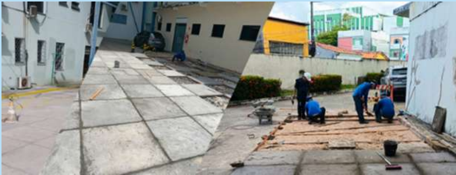
Figura 54: Correção do Piso de Concreto da ETA. Fonte: HU-UFMA (2024)
