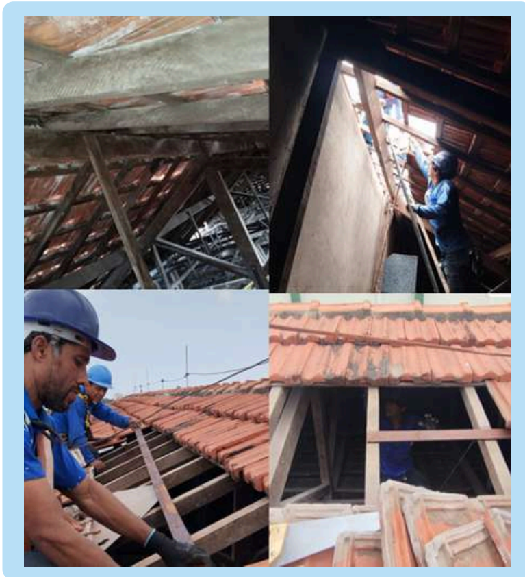
Figura 57: Recuperação de Telhado da Farmácia Fonte: HU-UFMA (2024)
