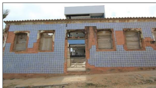
Figura 24 – Instituto do Fígado – Em reforma
