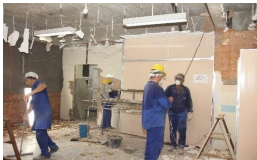
Fig.15 Reforma, ampliação e adaptação do prédio da Central de Esterelização
