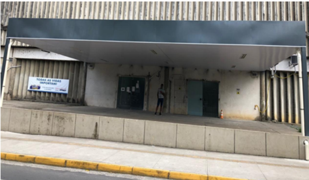
Figura 4. Recuperação e pintura da estrutura metálica da marquise da portaria 03
