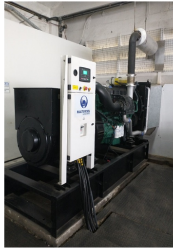
Figura 5. Substituição de grupo gerador da subestação
