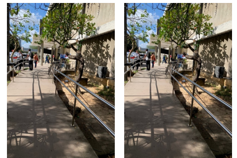
Figuras 9 e 10. Instalação de corrimão em aço inox no acesso à portaria 4
