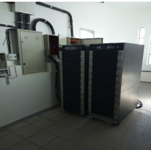
Figura 7. Adequação na sala do Nobreak no 5º pavimento
