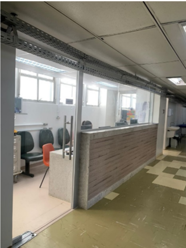
Figura 27. Requalificação do posto de enfermagem do 7º sul
