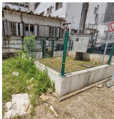
Figura 12. Malha de aterramento do PET-CT
