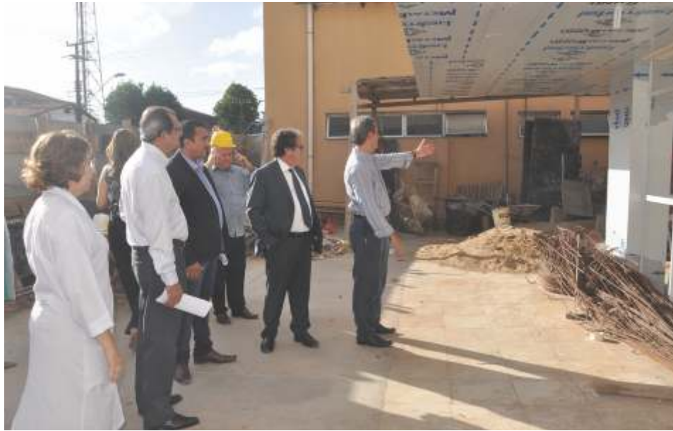
Visita a obras da MEAC
