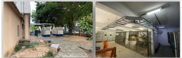
Figura 13. Obra de construção, instalação e fornecimento de uma subestação de 1.000kVA
