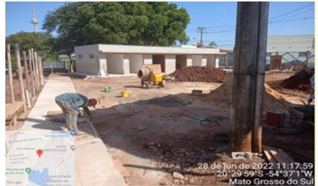
Figura 6. Construção do Abrigo de Resíduos
