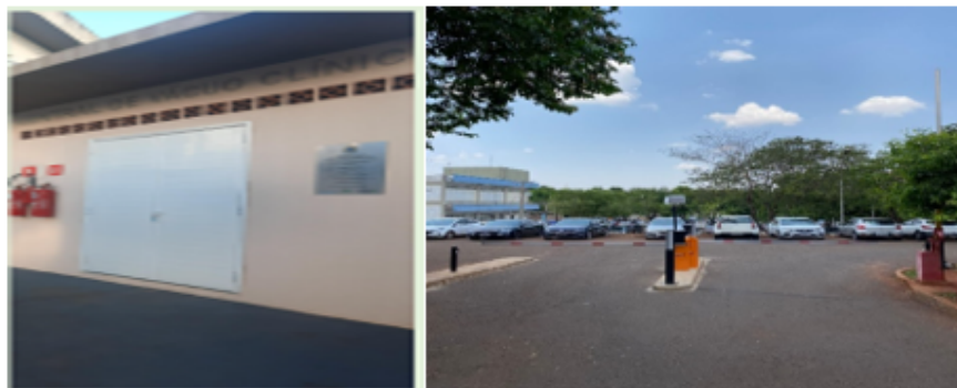
Figura 3. Obras inauguradas 2021 - Central de Vácuo e Instalação de cancelas
