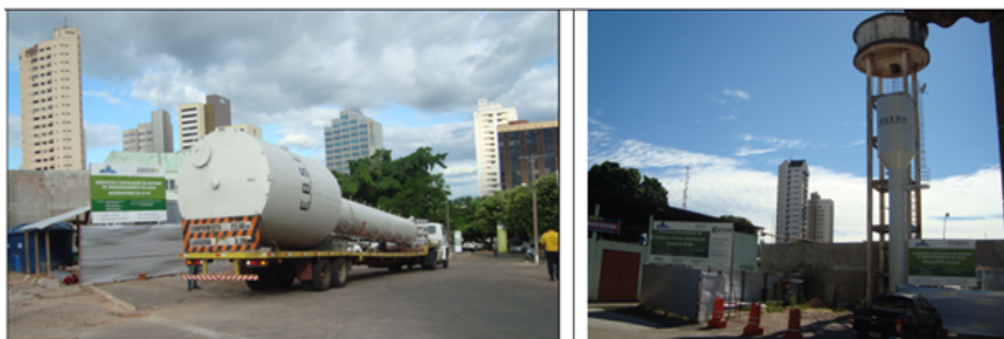
Figura 8. Instalação de reservatório de água tipo taça, 2019
