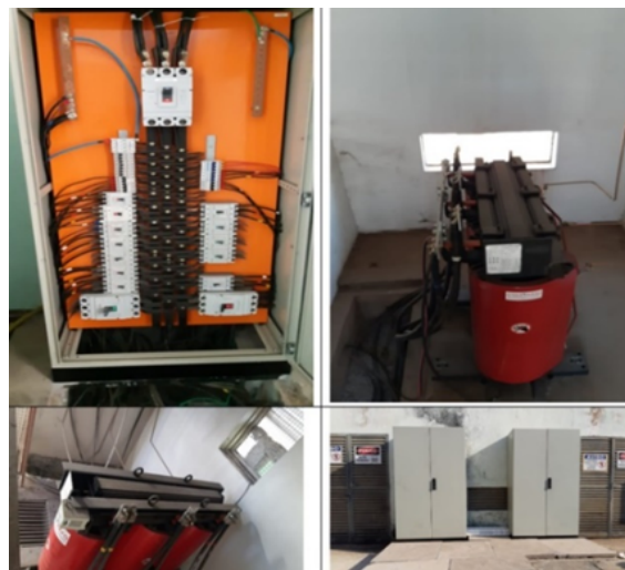
Figura 11. Quadros de energia, substituição de cabos e de transformador na cabine de energia, 2020
