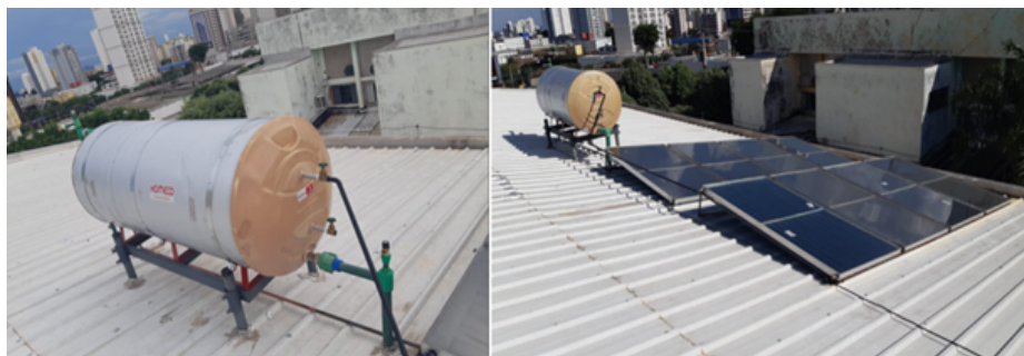
Figura 9. Aquecedores solares de água, 2020
