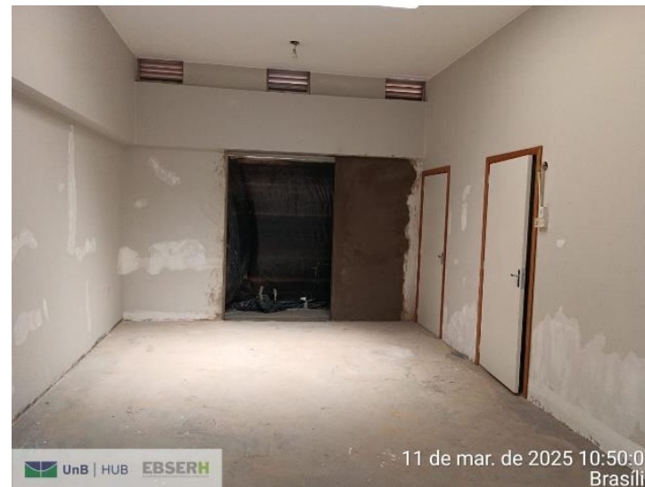
Hall da recepção da UDI antes e depois da adequação
