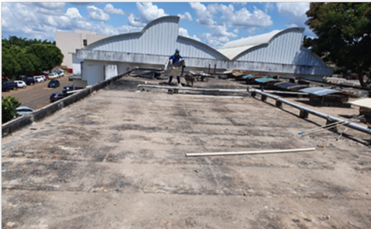
Figura 8. Impermeabilização Ambulatório II
