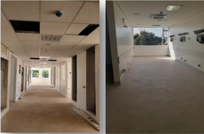
Figura 6. Obra da UCA
