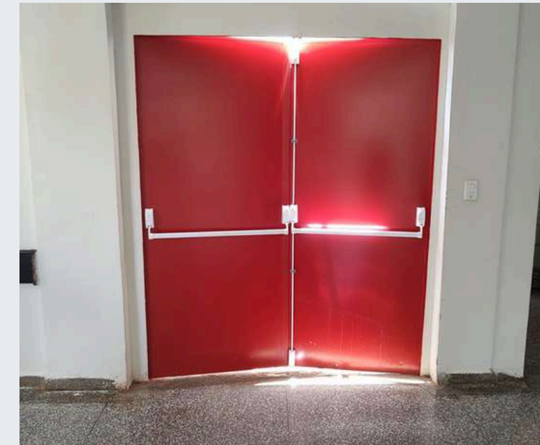
Início da obra de Prevenção e Combate a Incêndio e Pânico
