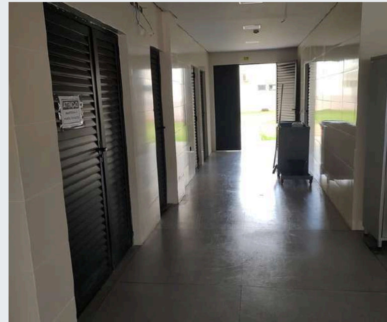
Término da Obra de Reforma e Ampliação da Lavanderia Hospitalar
