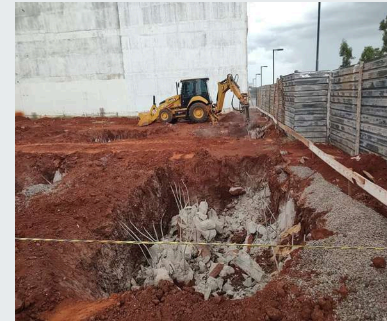
Início da obra da Fase 2 da UMC
