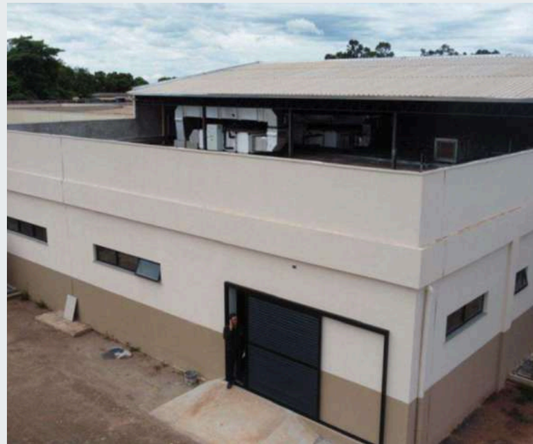
Término da Obra de Reforma e Ampliação da Farmácia Hospitalar
