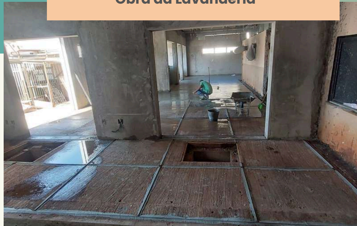
Obra da Lavanderia
