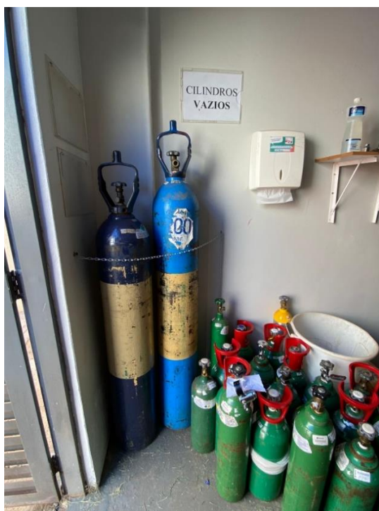
Figura 1 – Cilindros vazios segregados e presos por correntes.
