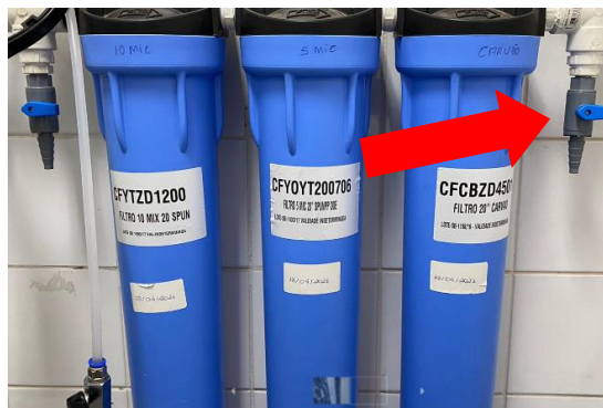
Figura 3 – Filtros MIC 10, MIC 5 e carvão, válvula para escoamento de água após fechamento do registro (seta vermelha).
