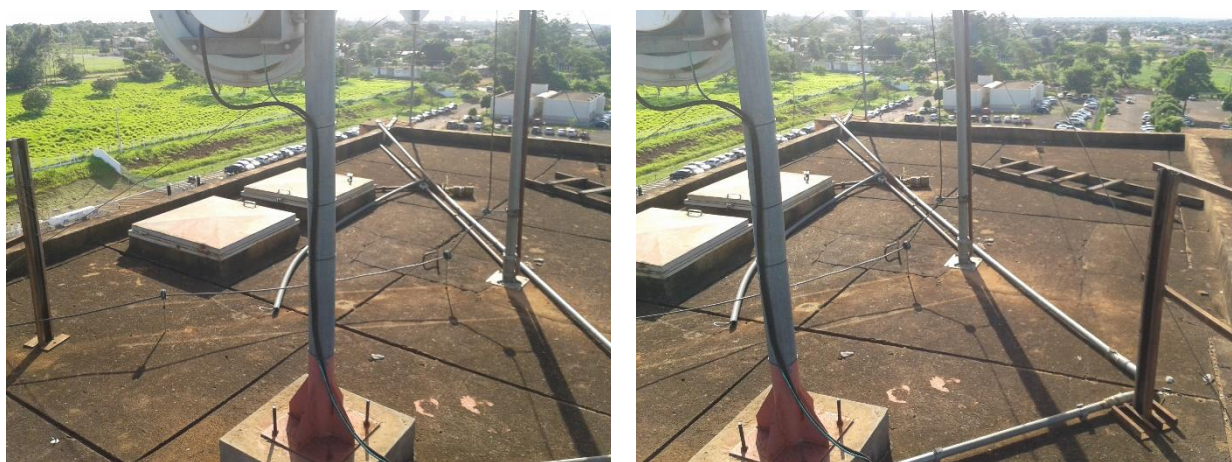
Reservatório Elevado de água
