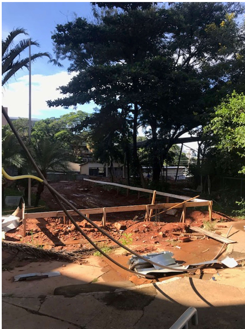
Figura 8 - Obra da Nova Portaria A
