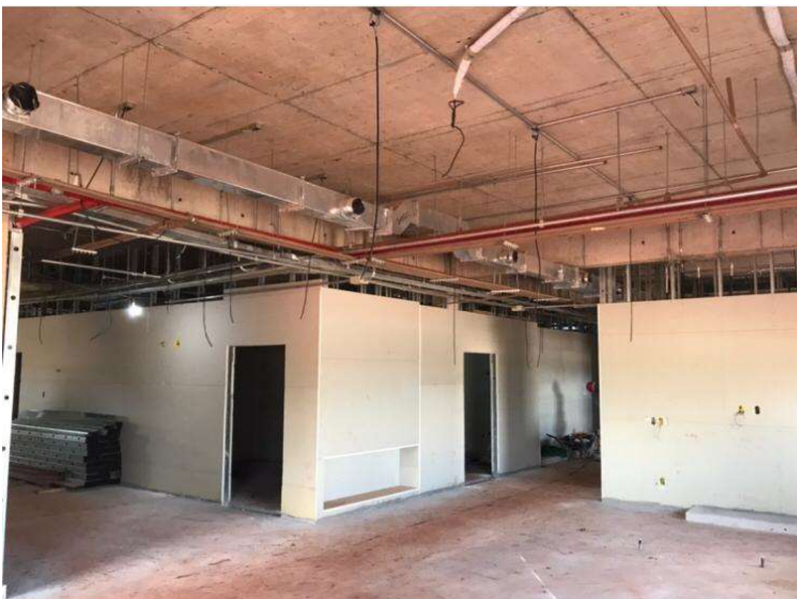
Figura 7 - Visão interna do Novo Prédio de Radioterapia
