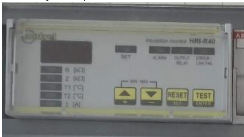
Figura 4 – Dispositivo monitor do sistema IT médico
