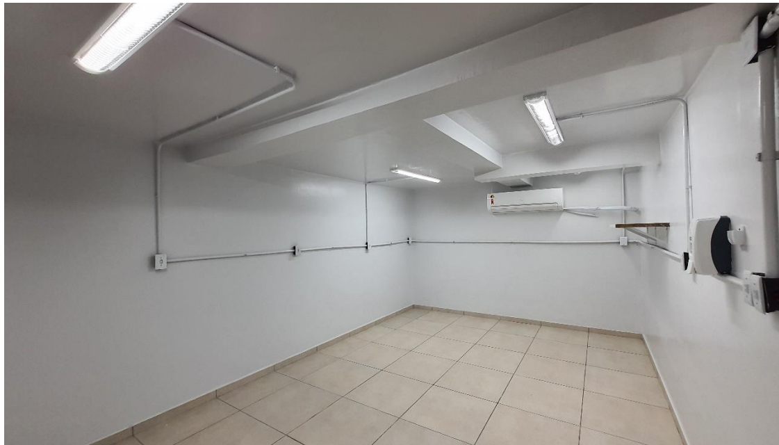
Figura 15 – Exemplo de linhas elétricas aparentes
