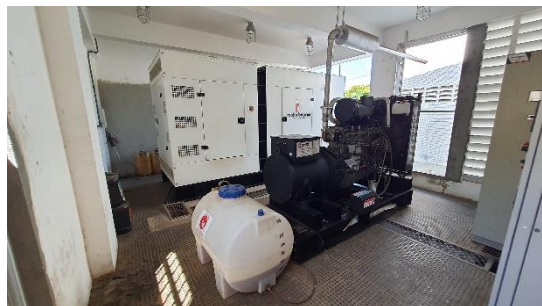
Figura 16 – Exemplos de grupo motor gerador
