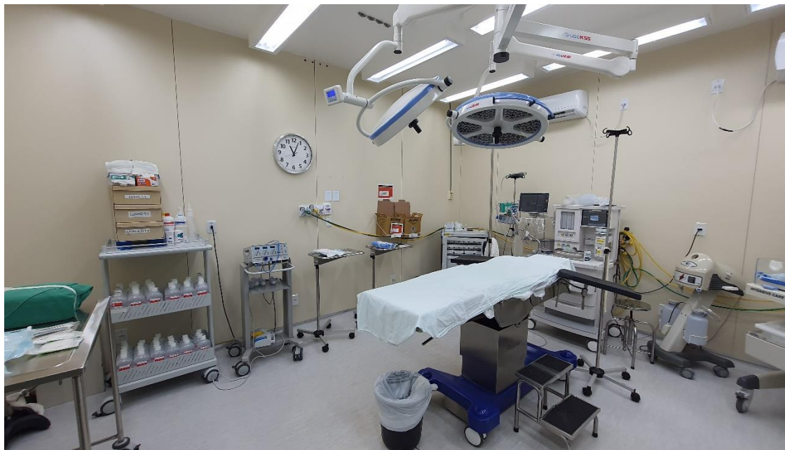
Sala de cirurgia do HUAB-UFRN sem a aplicação do piso condutivo, pois devido ao uso de anestésico não inflamável, a aplicação do componente é desnecessária, conforme a RDC-50.
