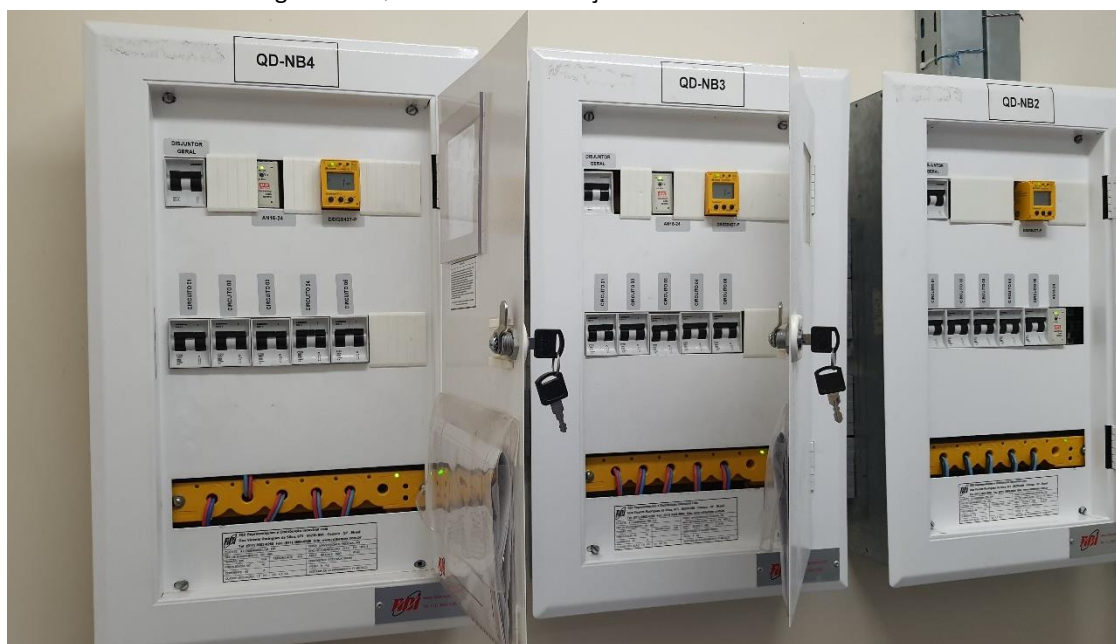
Figura 6 – Quadros de distribuição do sistema IT médico
