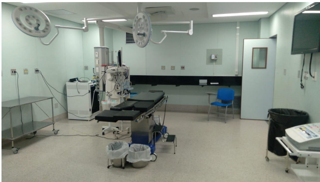
Piso condutivo instalado em um dos ambientes no HC-UFMG.
