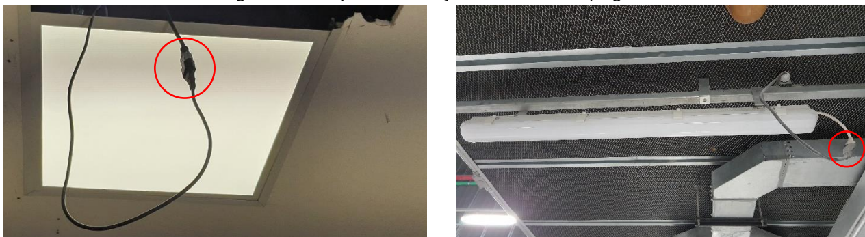
Figura 9 – Exemplos de utilização dos conectores plugáveis
