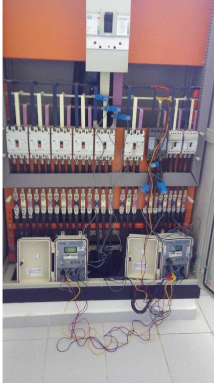
Figura 23 – Exemplo de multimetedor local das grandezas elétricas
