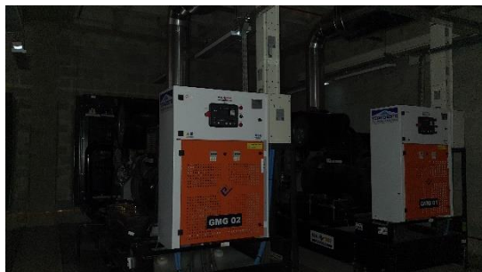
Figura 13 – Exemplos de grupo motor gerador
