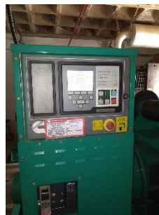
Figura 13 – Exemplos de grupo motor gerador
