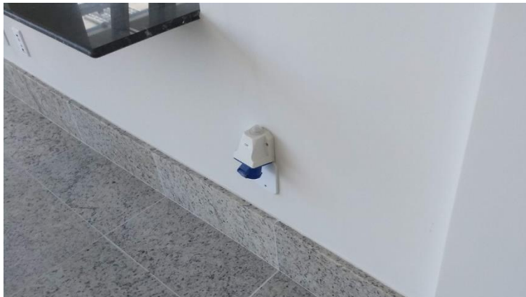
Figura 8 – Exemplo de aplicação e instalação das tomadas tipo industrial
