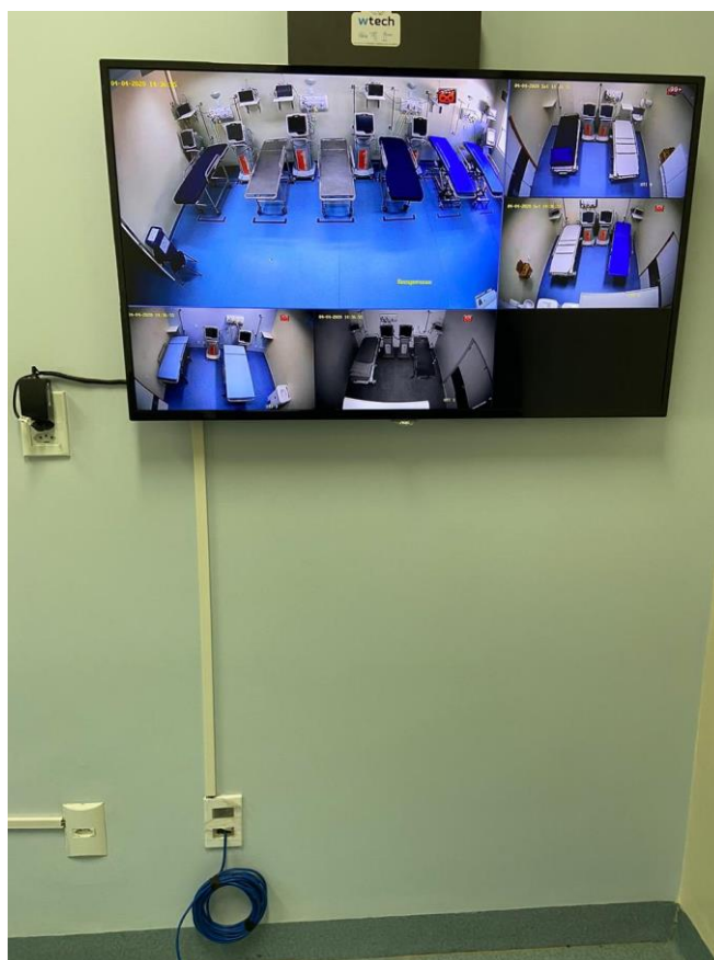
Figura 05 – Central de monitoramento de leitos Covid-19 por câmeras implantada em TV Full HD e DVR de 1Tb (Fonte: Arquivo pessoal, DLIH/HUPAA/Ufal/Ebserh).
