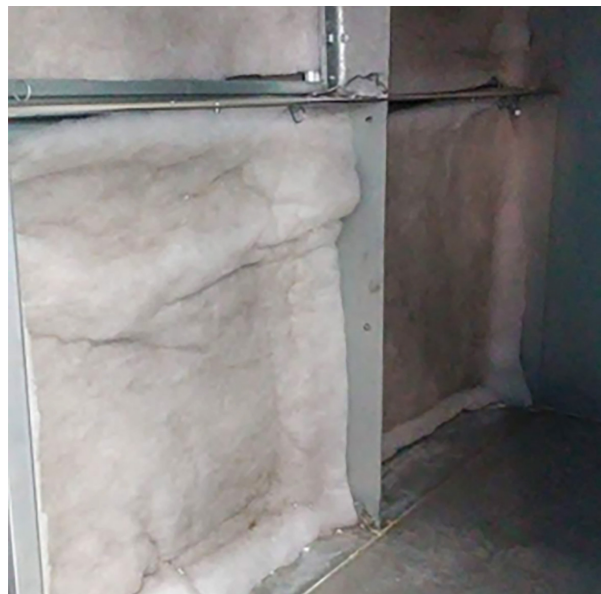
Figura 33 – Nesta foto temos o uso de manta G no lugar de células de filtro G
