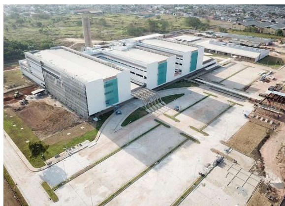
Figura 60: Hospital Universitário da Universidade Federal do Amapá, vista aérea do conjunto (fonte: HU-UNIFAP).
