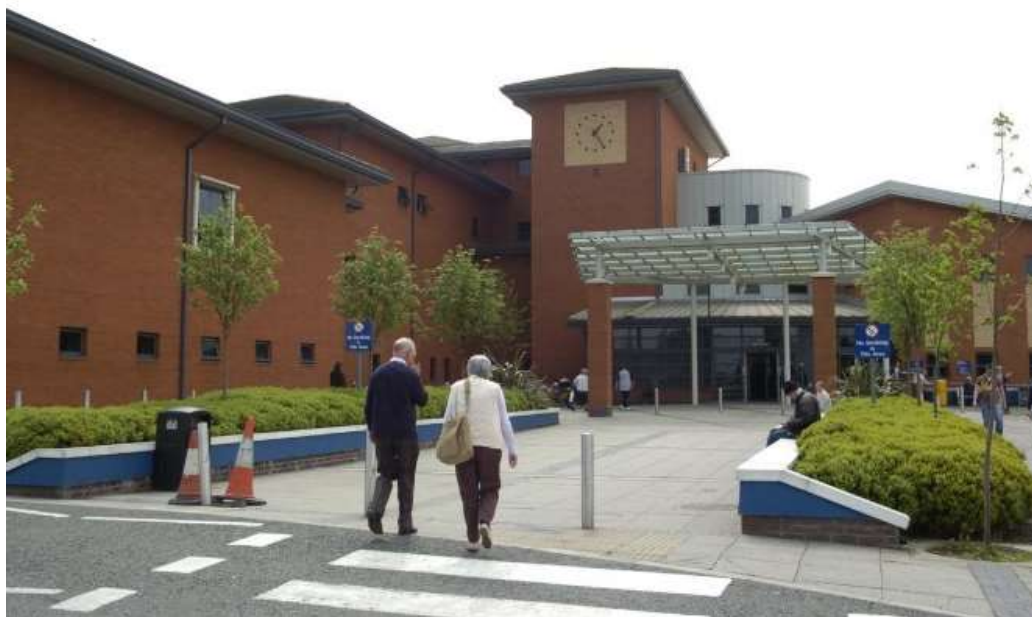
Figura 77: Exemplo de entrada principal com acessibilidade direcionada ao conforto do pedestre. HOSPITAL OF SOUTH MANCHESTER: WYTHENSHAW HOSPITAL – MANCHESTER, U.K.
