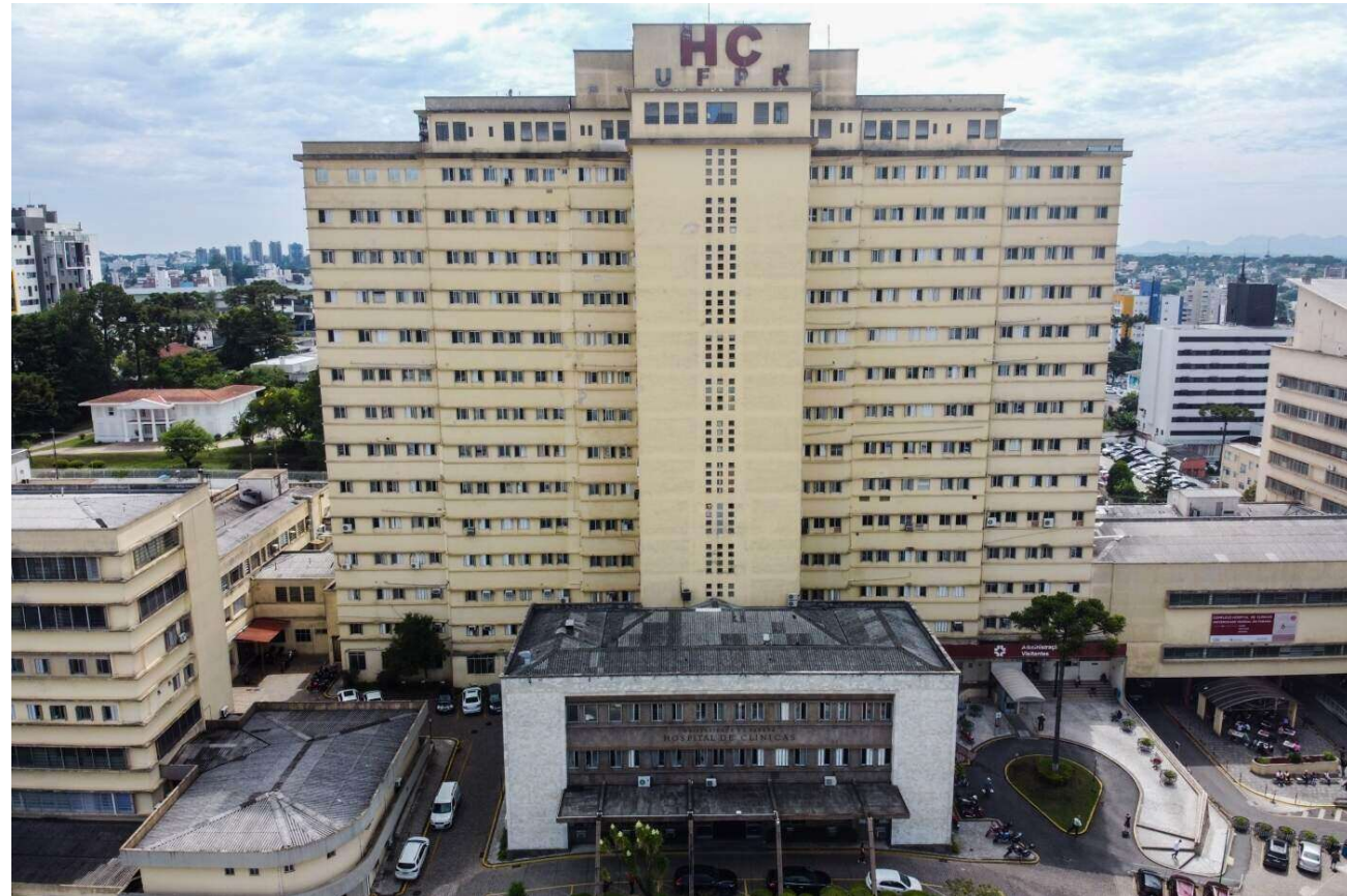
Figura 1: Prédio central do Hospital de Clínicas da UFPR (fonte: Cadastro de Infraestrutura, SMPO Ebserh).
