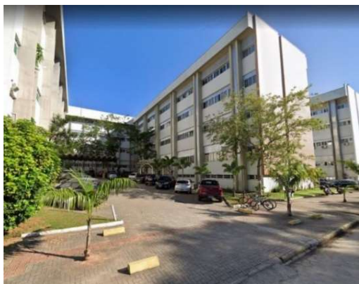
Figura 58: Acesso veicular do HU – UFSC. piso de blokret hexagonal, com estacionamentos complementares em blokret retangular (fonte: Google Street View).
