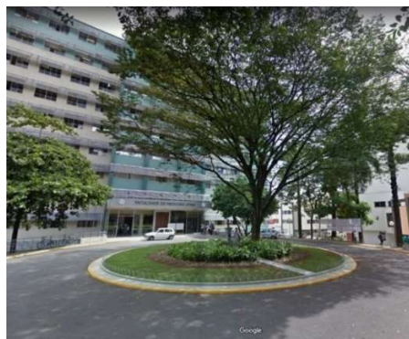
Figura 56: Acesso principal do HC – UFMG em piso asfáltico. (fonte: Google Street View).
