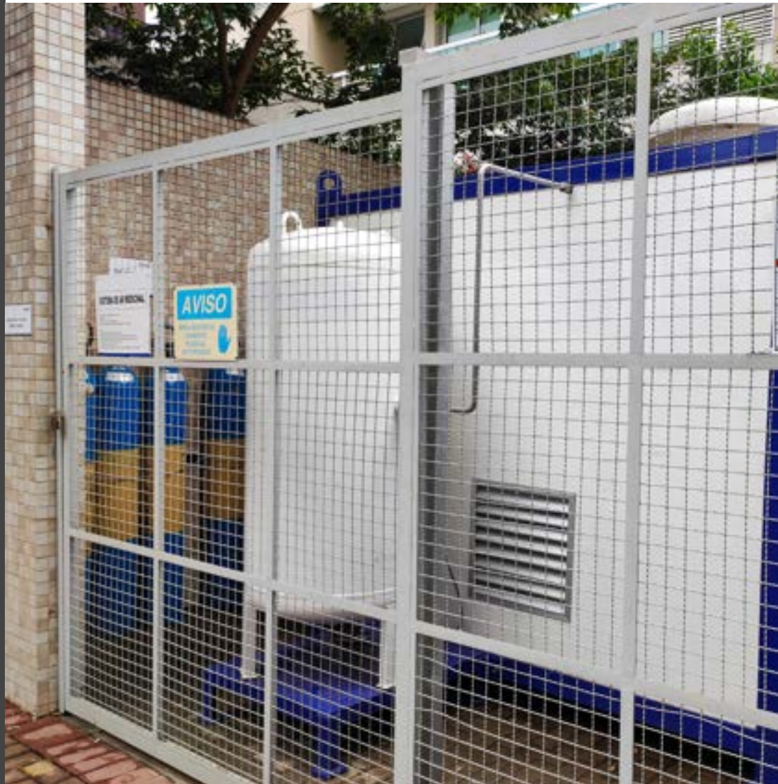
Figuras 97 e 98 – Central de Ar Comprimido e Central de Vácuo
