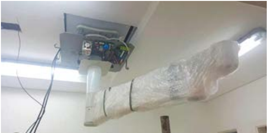
Figuras 35 e 36 – Detalhe da Base e Haste de Foco Cirúrgico Fixados na Estrutura do Teto da Sala Cirúrgica
