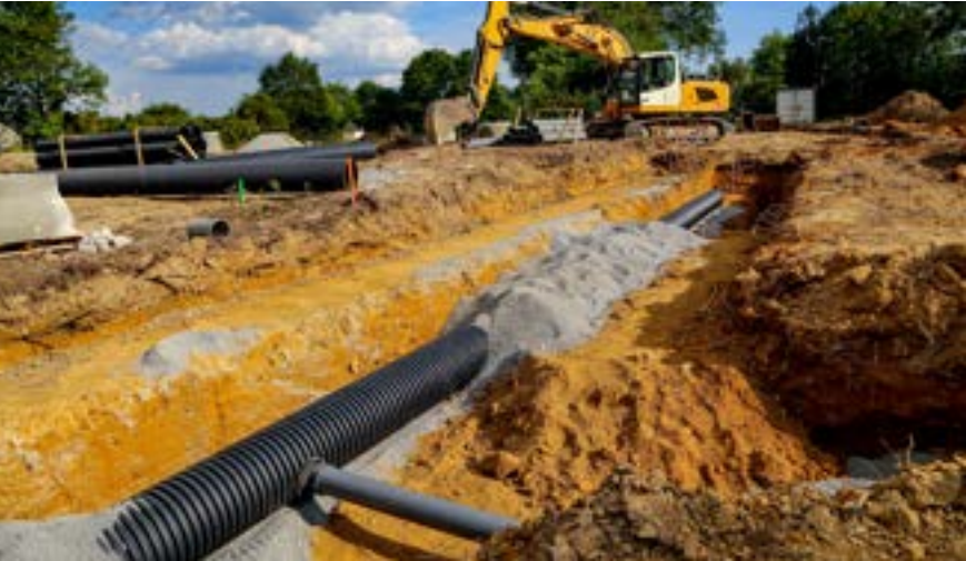
Figura 88 – Drenagem de Lençol Freático
