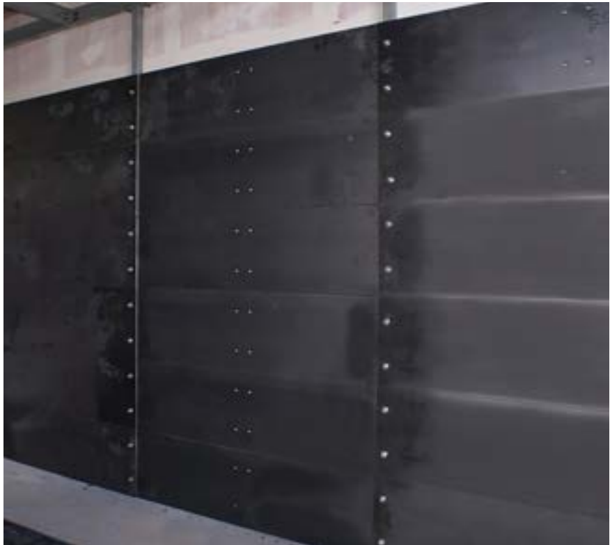
Figura 50 – Área Protegida com Manta de Chumbo
