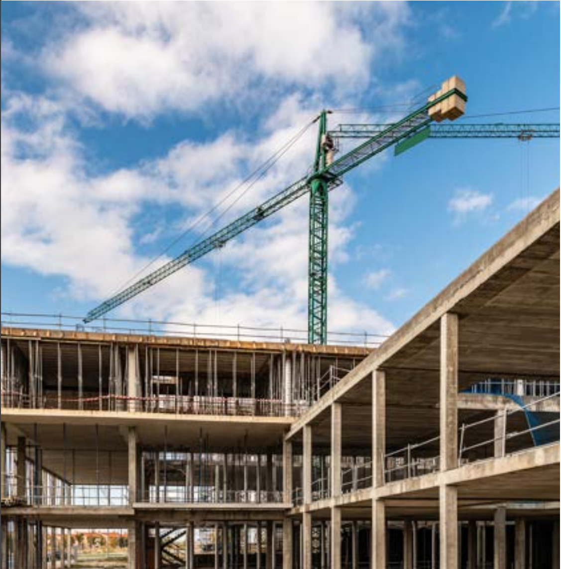
Figura 37 – Estrutura de Concreto
