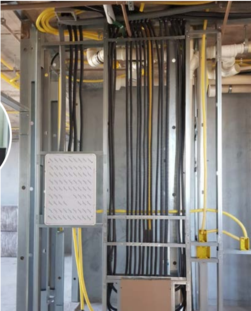
Figura 17 – Protótipo de Instalações no Drywall
