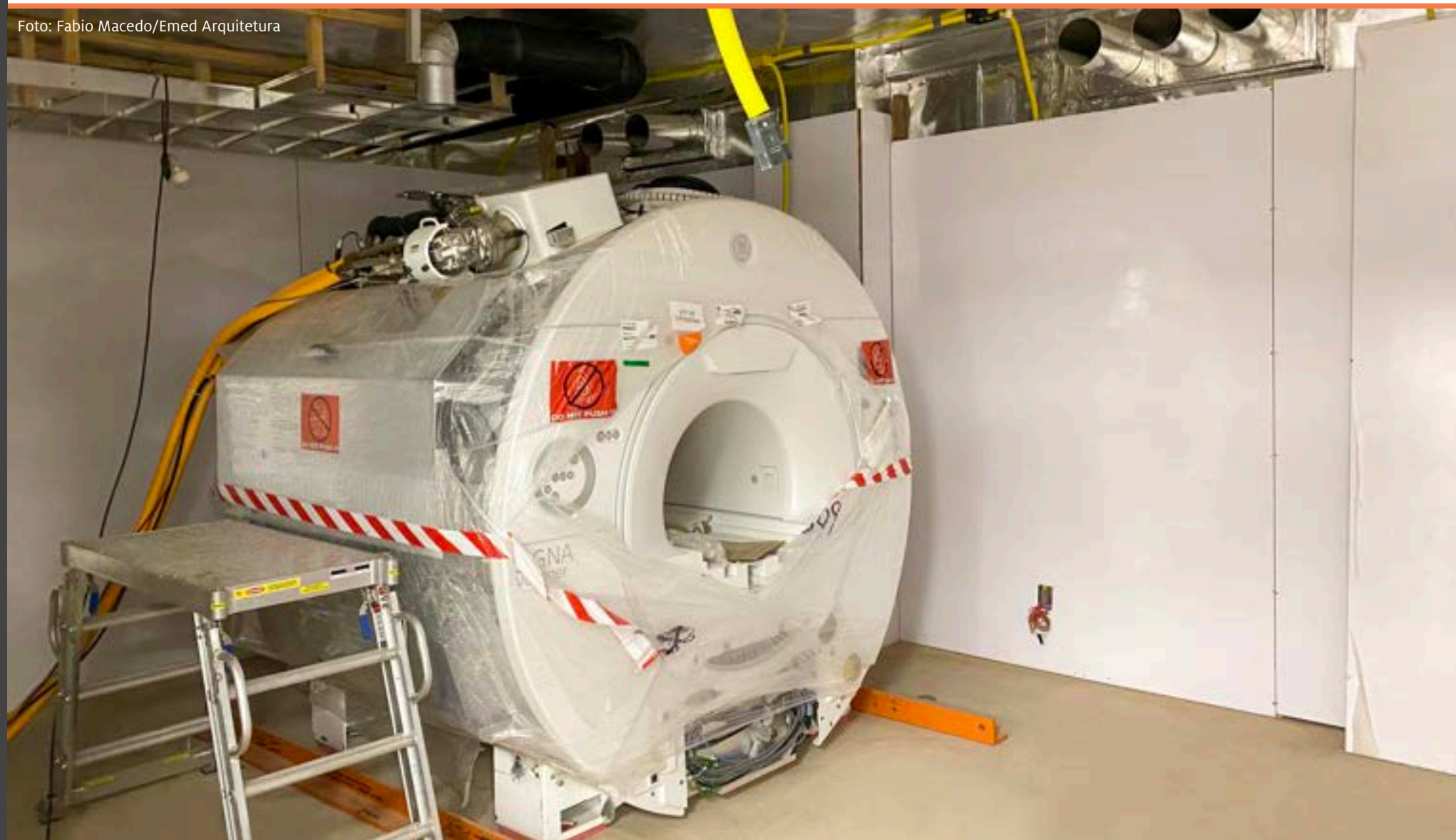
Figura 55 – Detalhes da Execução da Gaiola de Faraday
