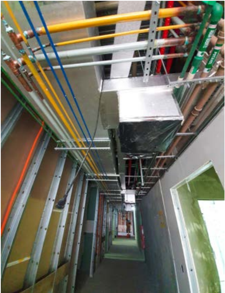
Figuras 147 e 148 – Rede de Dutos Instalados com a Boca Protegida Durante a Obra
