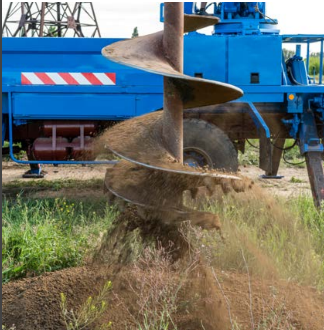
Figura 32 – Estaca de Hélice Contínua
