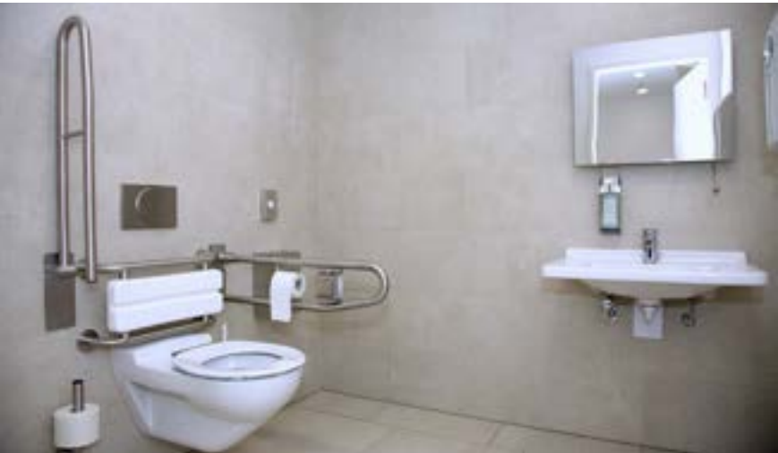
Figura 13 – Protótipo de Banheiro Executado para Avaliação das Equipes Hospitalares e de Limpeza
