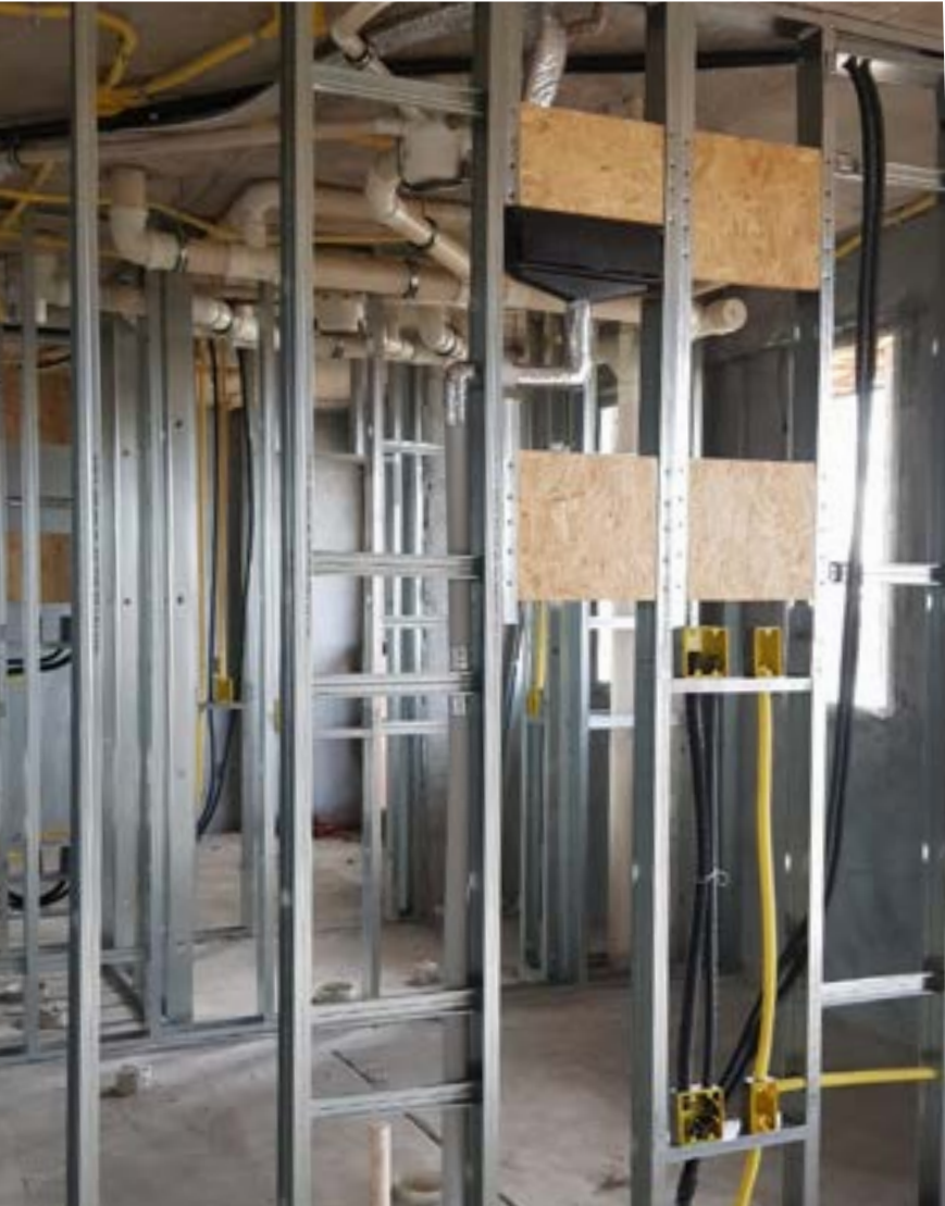
Figura 44 – Reforços Instalados nos Perfis
