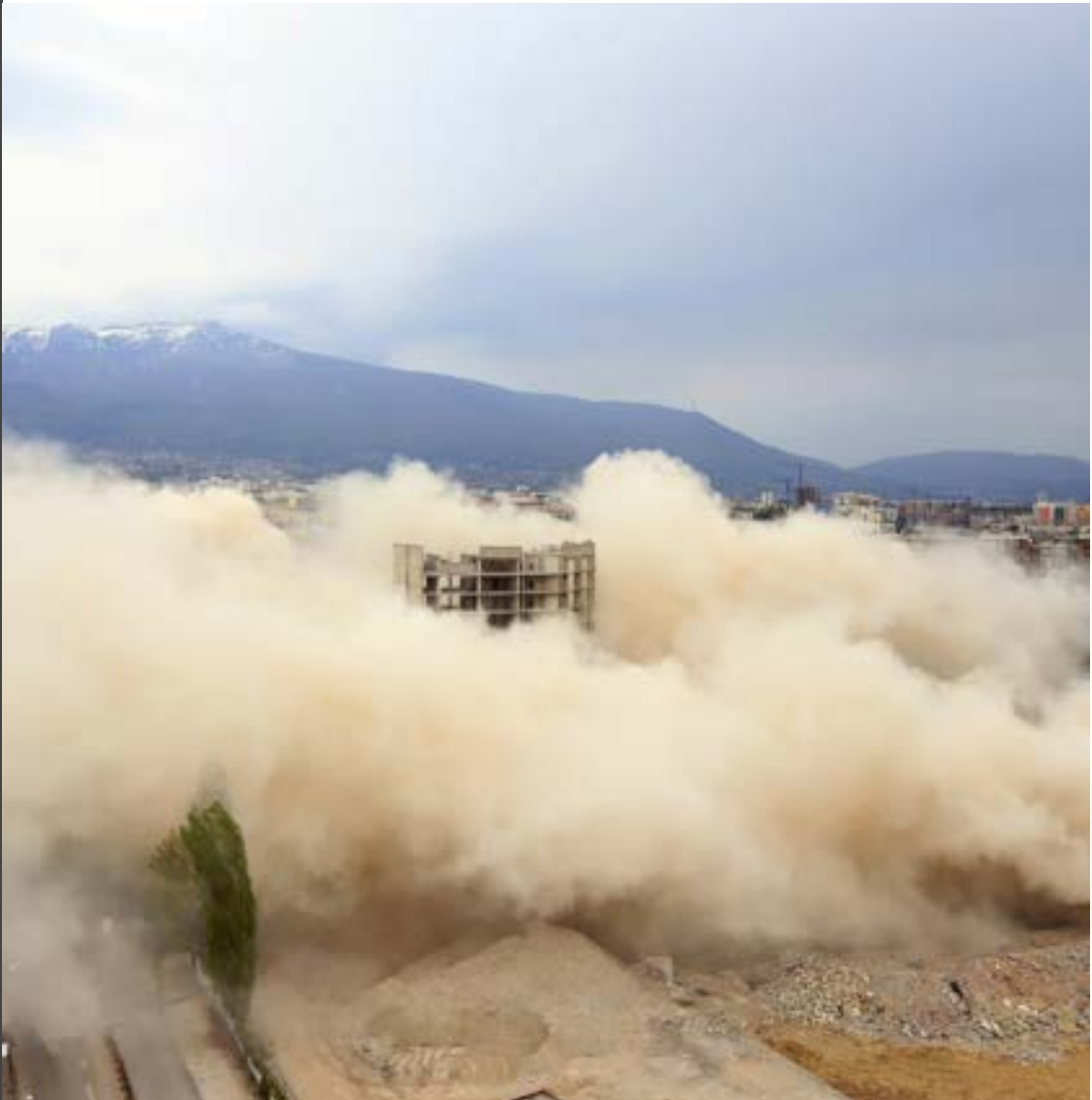
Figura 25 – Demolição com Explosivos
