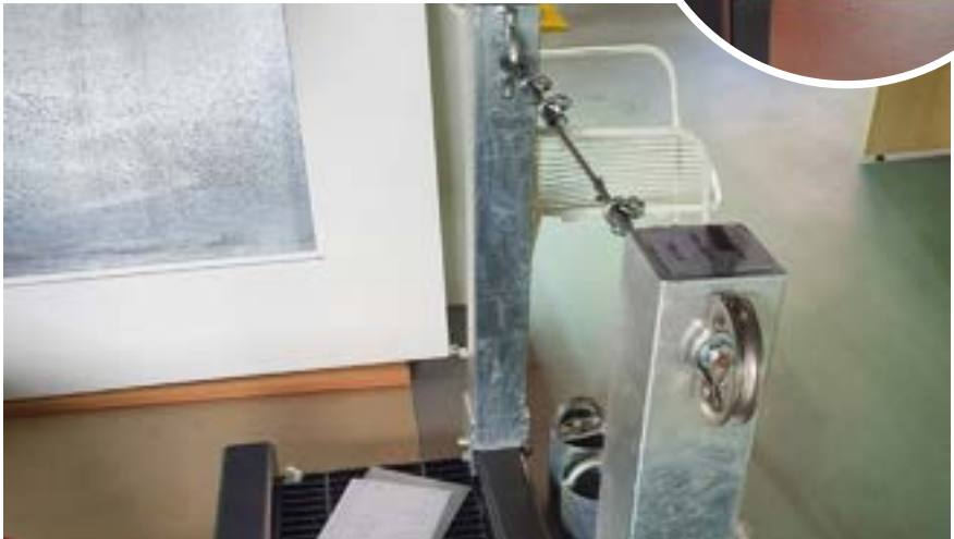
Figura 16 – Detalhe da Fixação da Linha de Vida Exigida pela Equipe de Segurança do Trabalho
