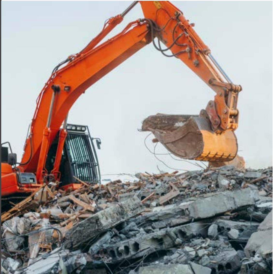
Figura 23 – Demolição Mecânica
