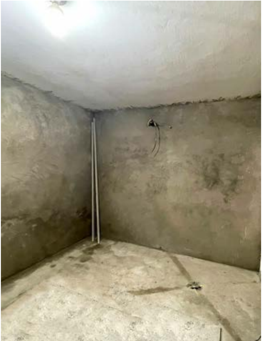
Figura 49 – Área Protegida com a Massa Baritada
