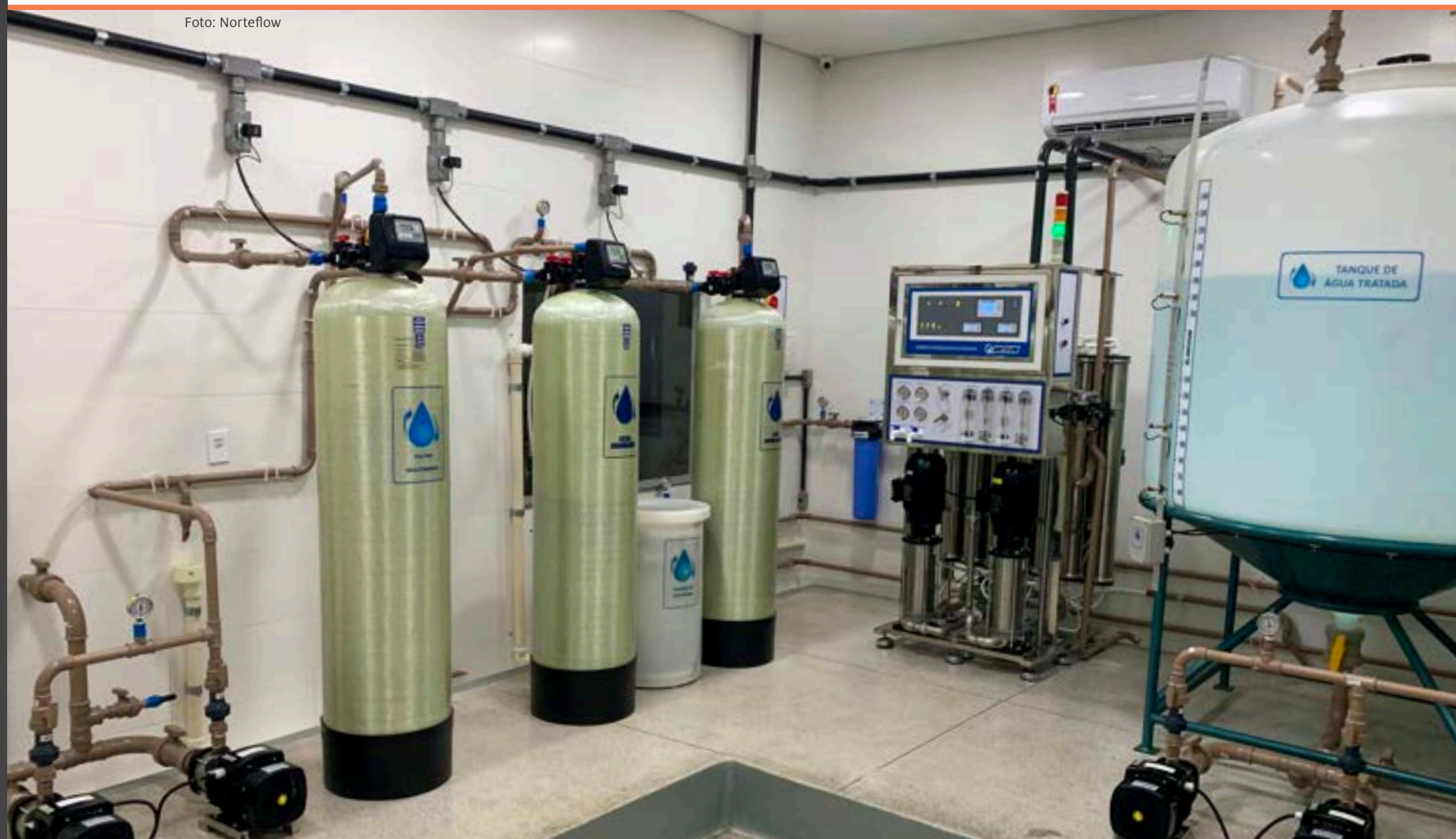
Figura 79 – Sistema de Tratamento de Água
