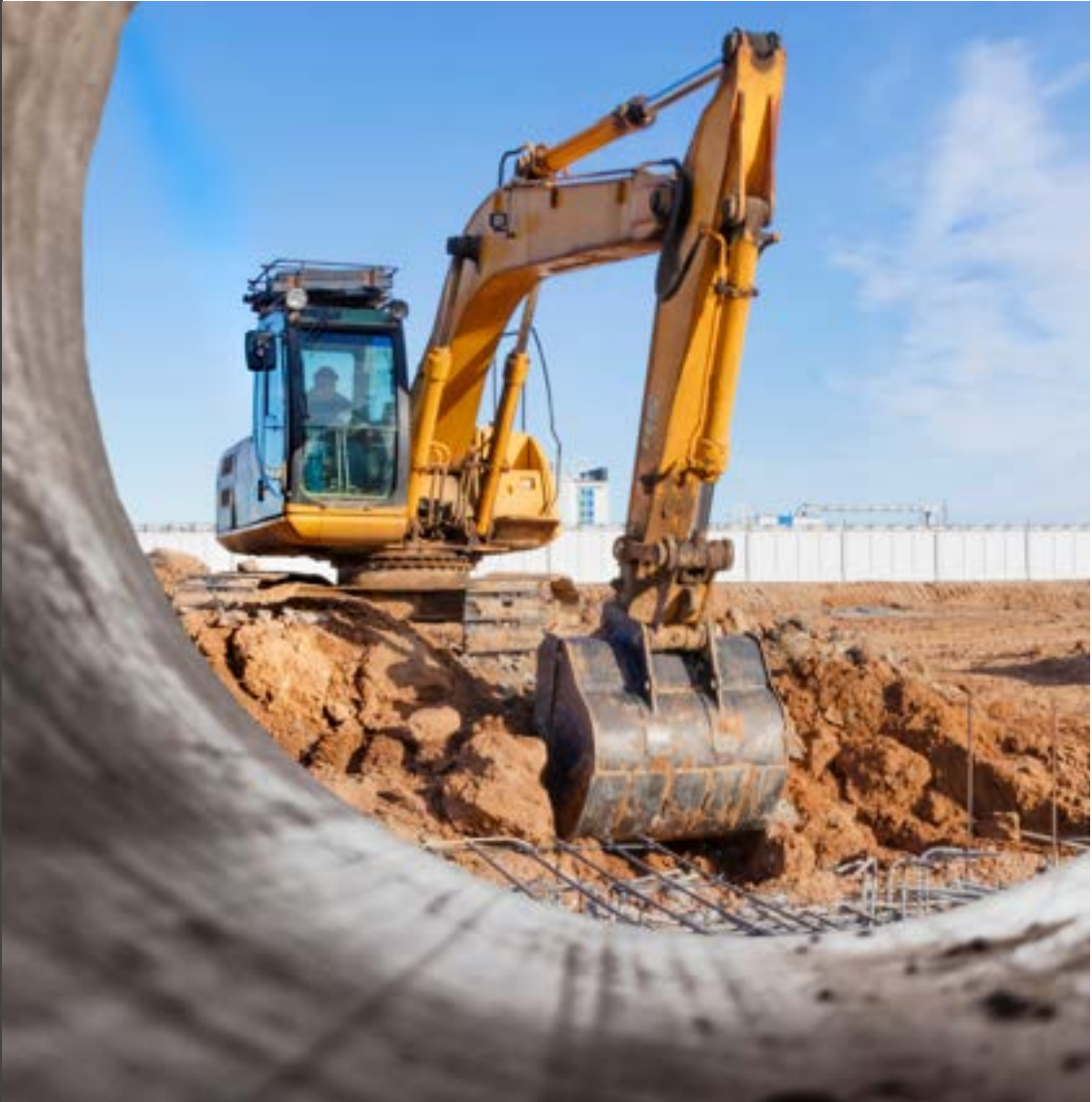
Figura 26 – Remoção de Terra para Execução de Subsolo
