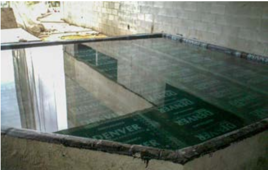
Figuras 40 e 41 – Teste de Impermeabilização em Áreas Interna e Externa
