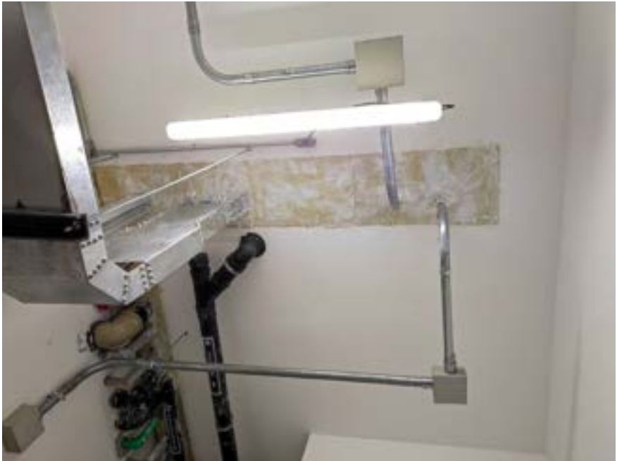
Figura 104 – Selagem de Tubulações em Shafts
