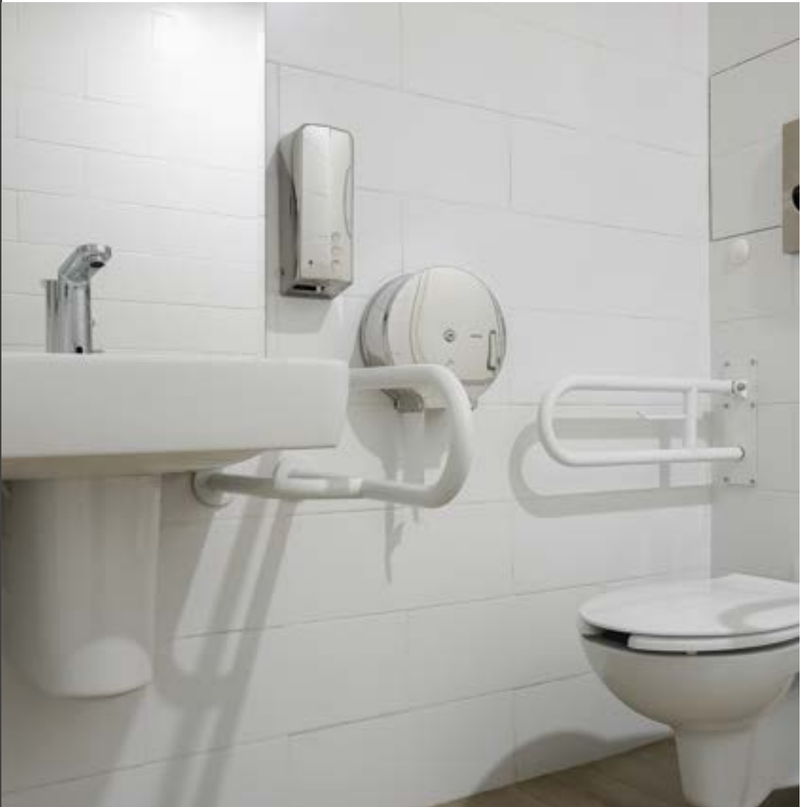
Figura 56 – Cerâmica Instalada em Banheiro Hospitalar
