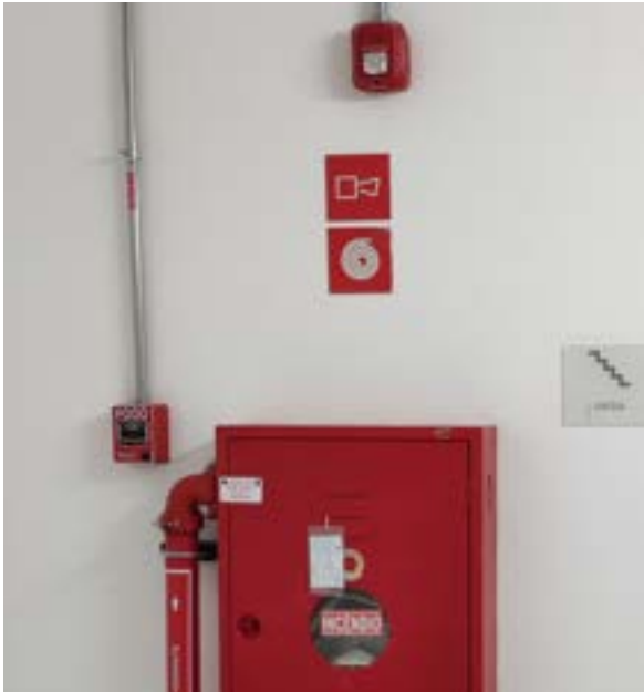
Figura 109 – Botoeira Junto ao Hidrante e Sinalizador Visual
