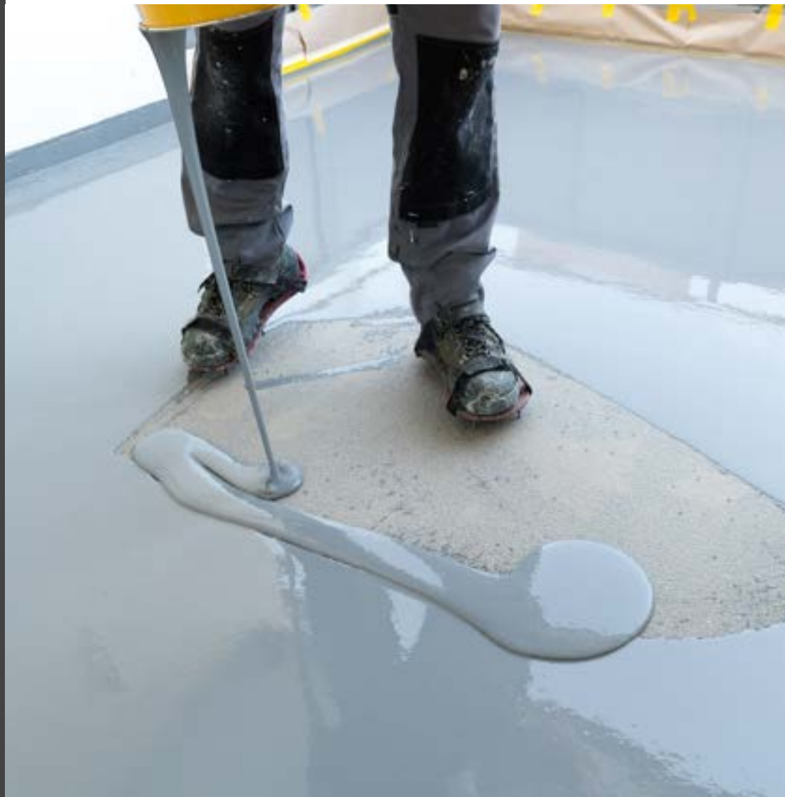
Figura 67 – Piso de Resina Autonivelante
