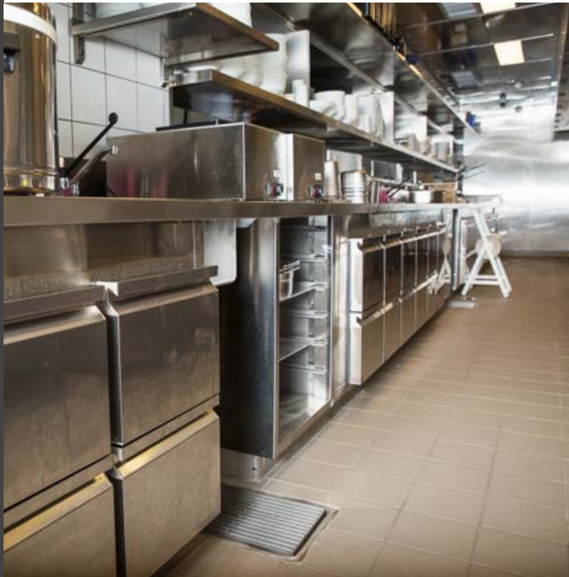
Figura 65 – Porcelanato Técnico Instalado
