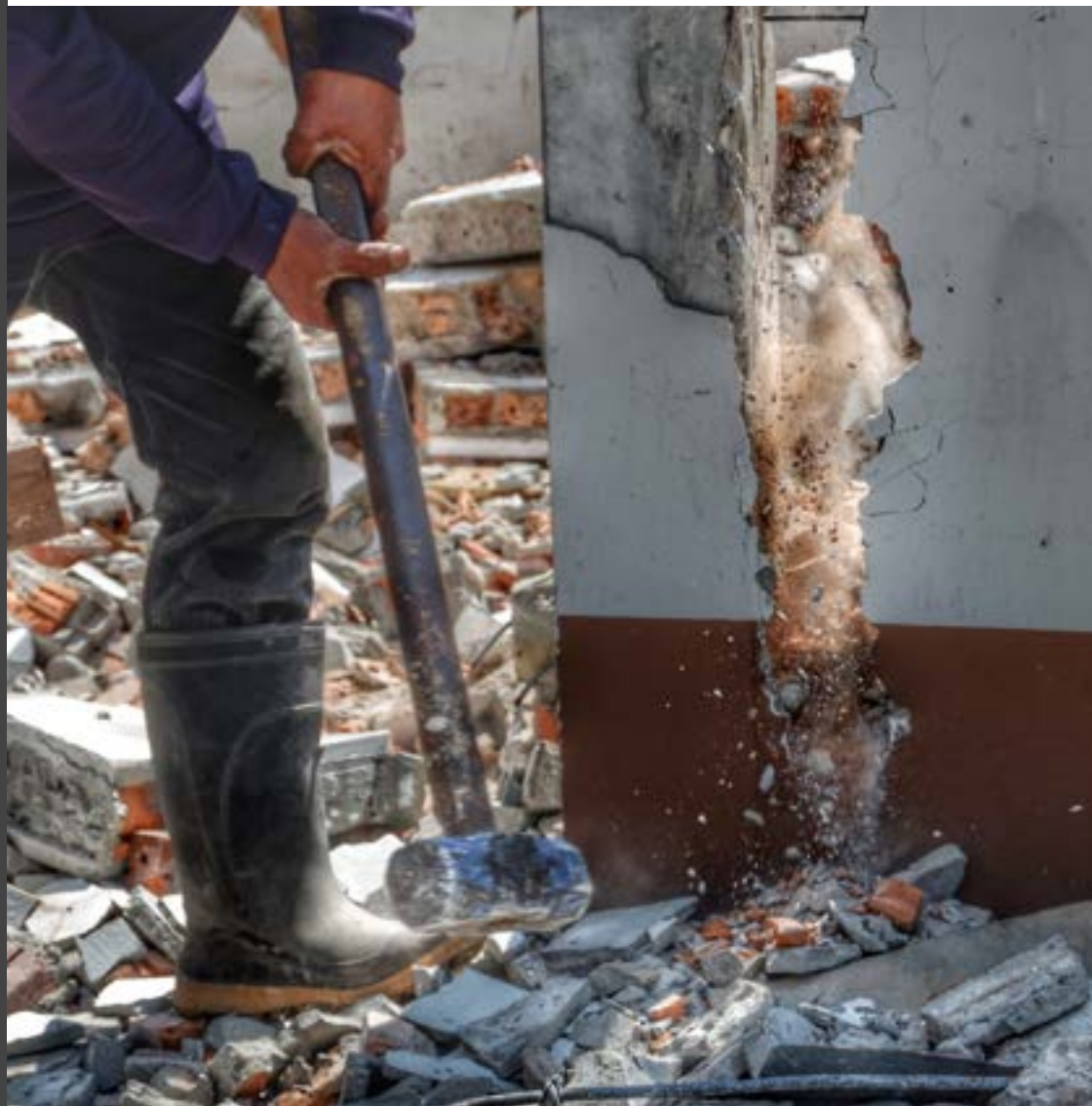
Figura 24 – Demolição Manual
