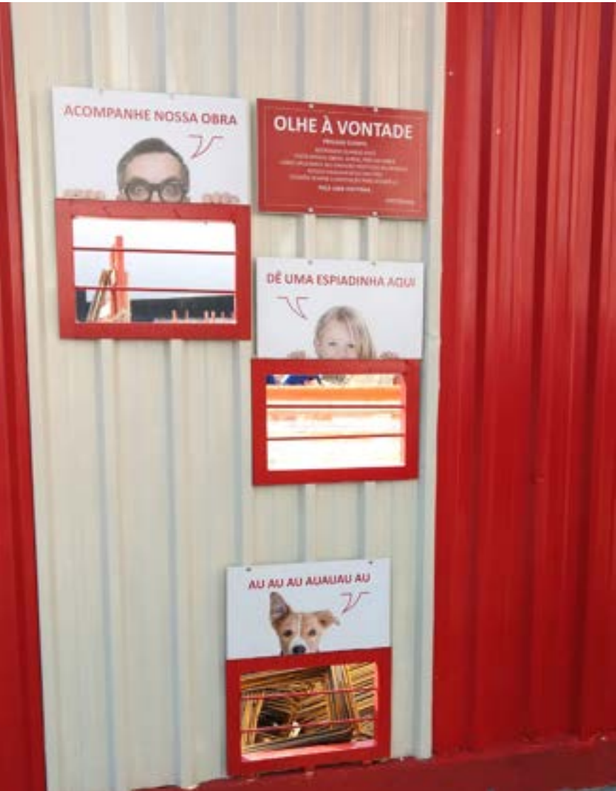
Figura 9 – Tapume com Visibilidade da Obra para Vizinhos Externos
