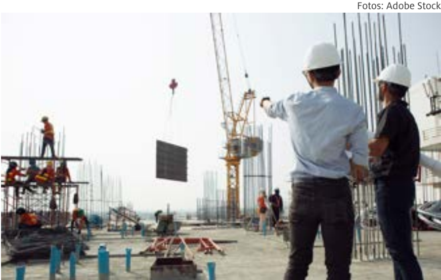
Figura 10 – Visita de Consultor na Obra
