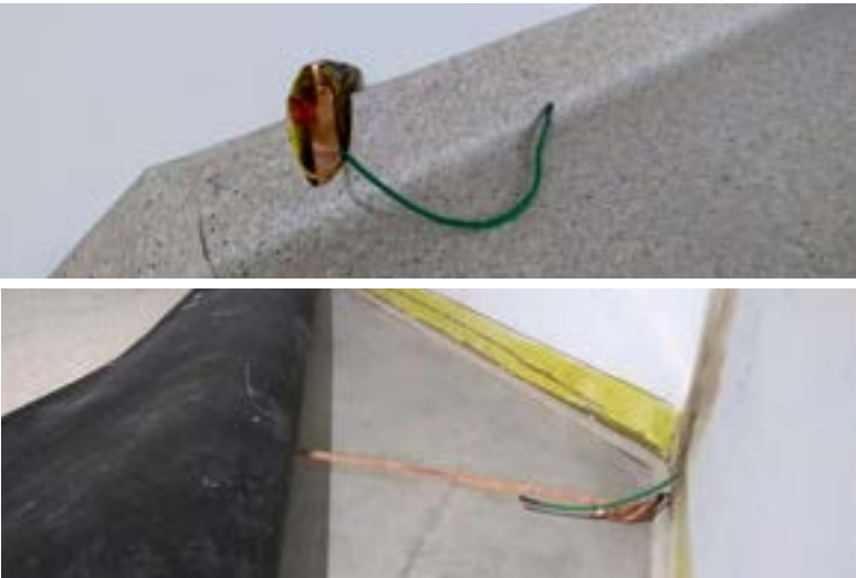
Figuras 62 e 63 – Detalhes da Instalação da Malha de Aterramento Sob o Piso e Interligação na Prumada de Aterramento do Edifício
