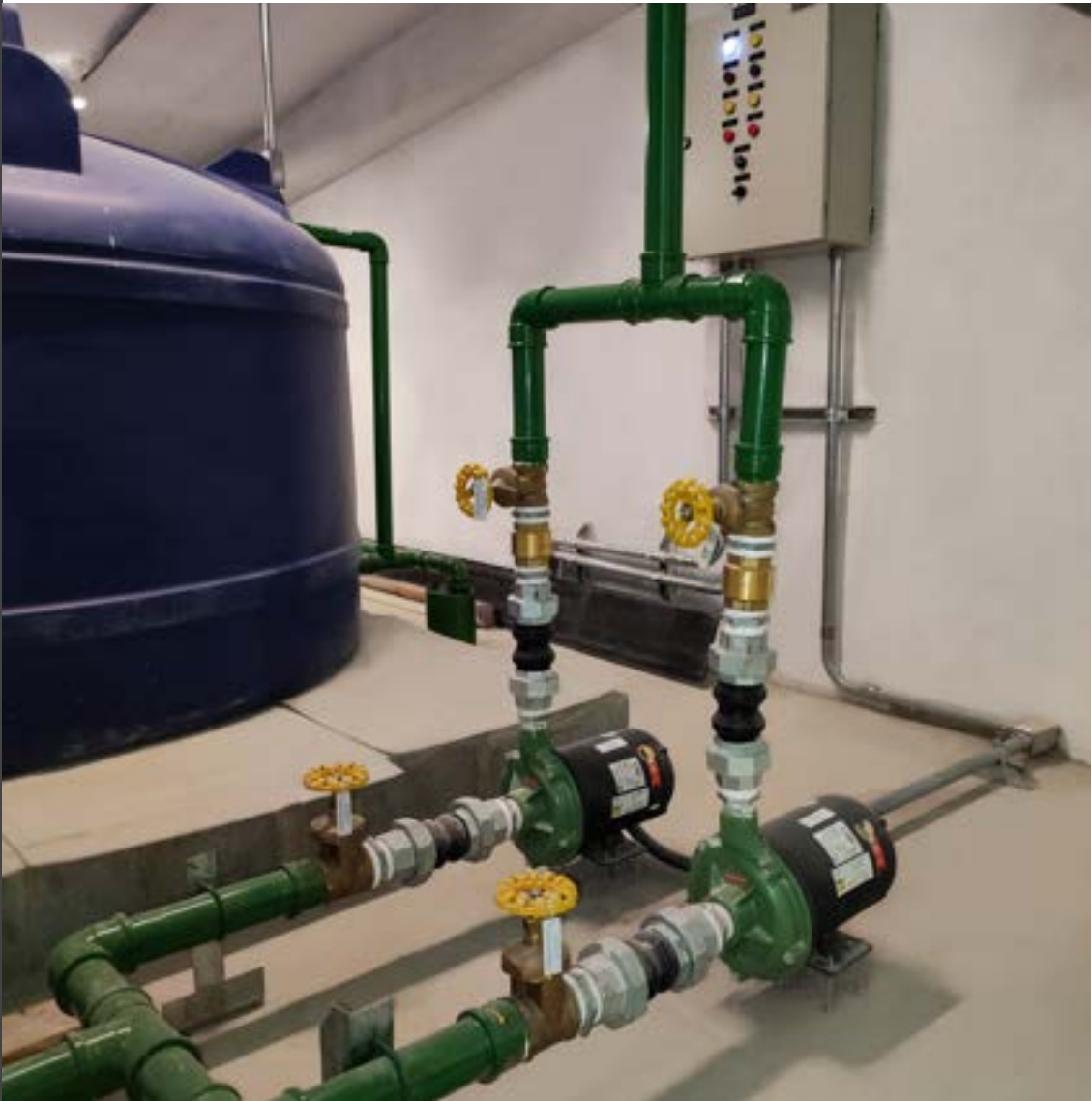
Figura 72 – Instalação de Casa de Bombas
