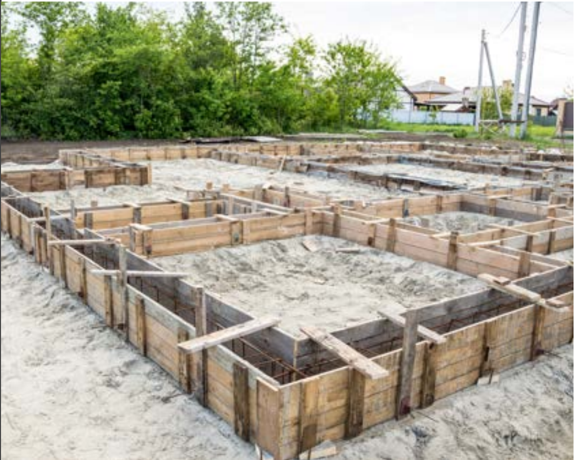
Figura 28 – Sapata Corrida
