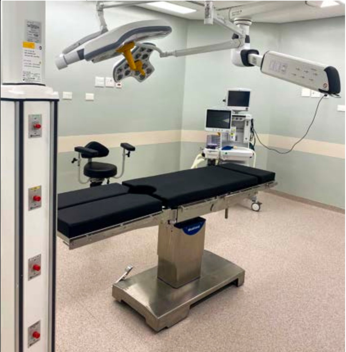
Figura 61 – Sala Cirúrgica com Piso Vinílico Condutivo
