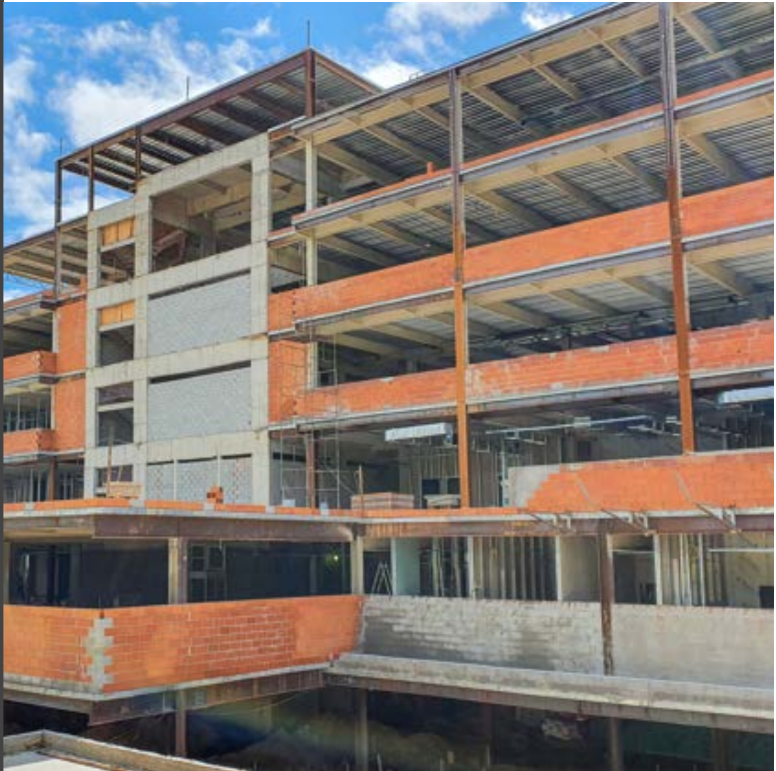
Figura 2 – Unidade Hospitalar em Construção
