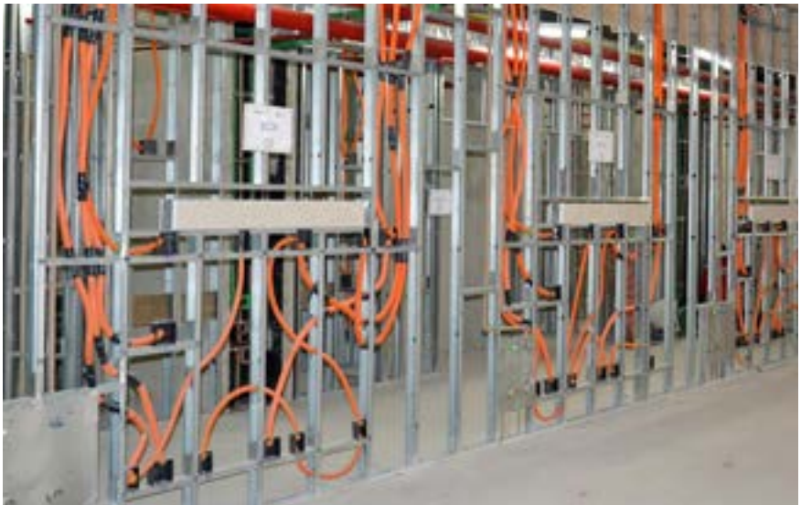
Figuras 42 e 43 – Instalações são executadas assim que os perfis são posicionados
