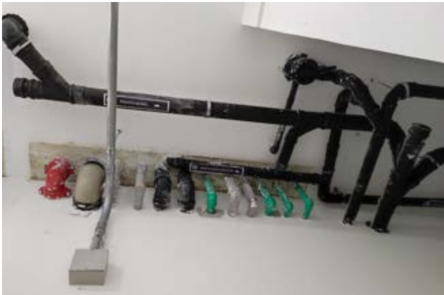
Figuras 102 e 103 – Selagem da Passagem de Tubulações em Shaft
