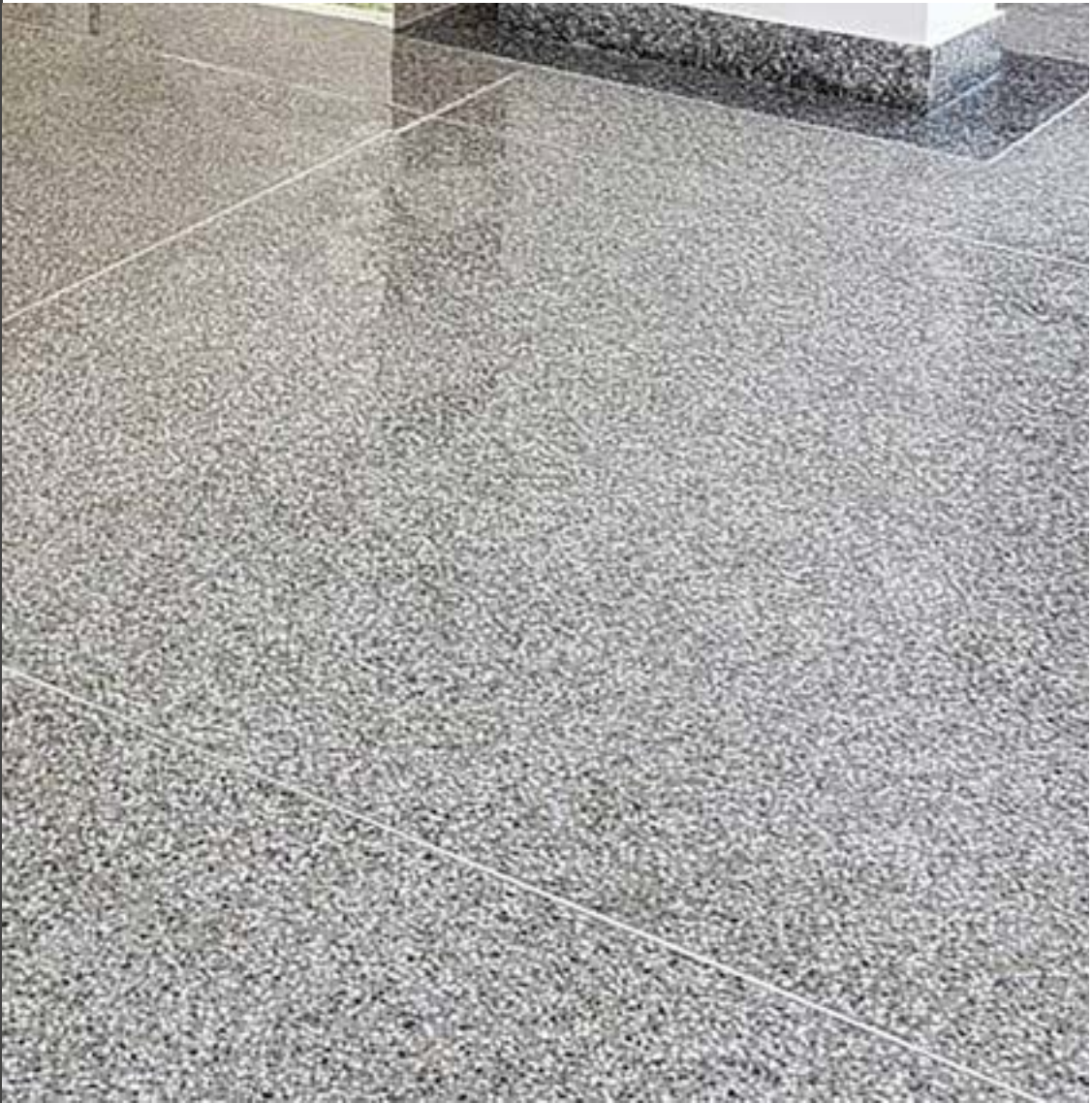
Figura 68 – Piso de Granilite Instalado em Hospital
