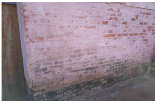
Tijolos em desagregação
