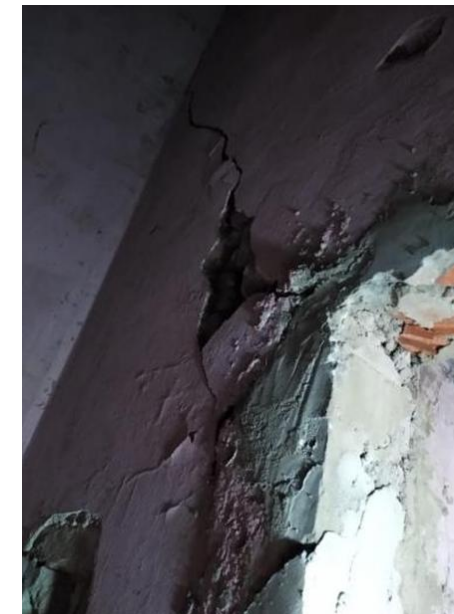
Trinca em vértice
